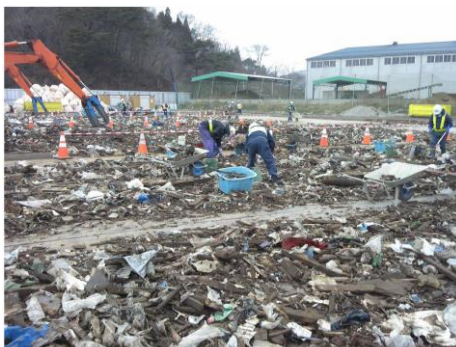
図 4-6-1 一次仮置場における処理
