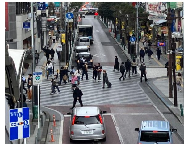
交通広場の出口交差点の現況
