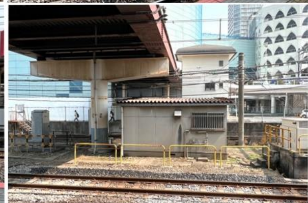
駅関連施設や様々な設備が設置
