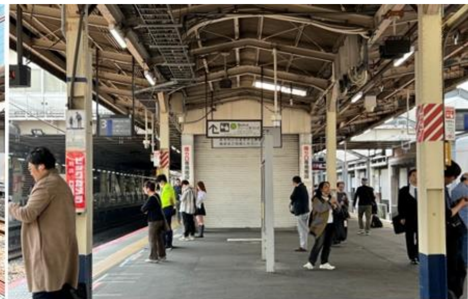
新設改札口により撤去が想定される臨時改札口階段
