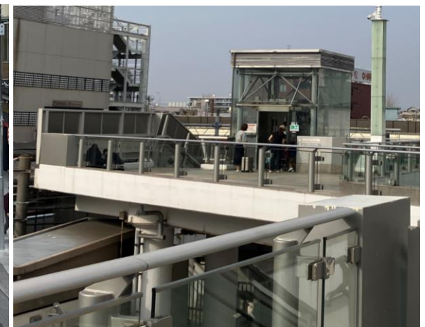
エレベータの現況
