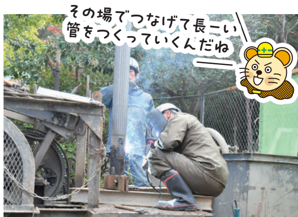
鉄管を溶接してしっかりつなげます
