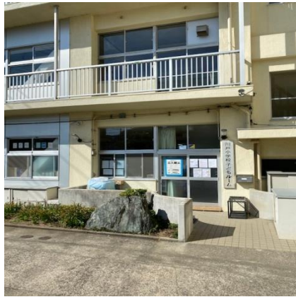
専用室入口 (旧こどもルーム)
