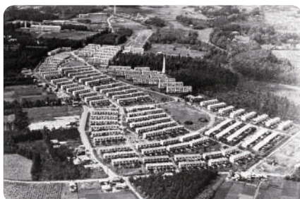
建設当時の光ヶ丘団地
