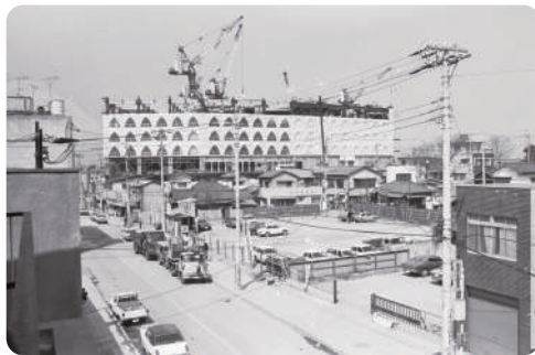
そごう柏店建設現場
