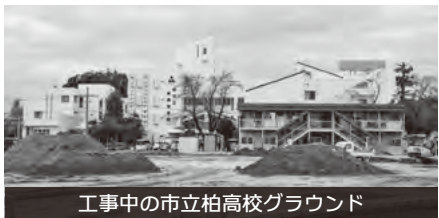
工事中の市立柏高校グラウンド
