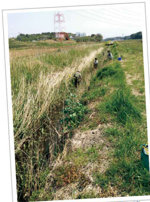
河川改修前の染井入落
