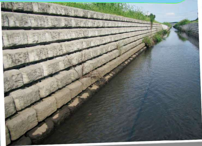
河川改修後の染井入落
