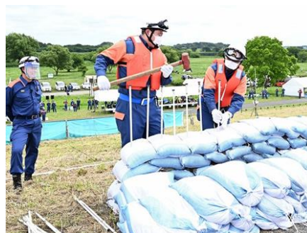
▲ 積土のう工法の様子
