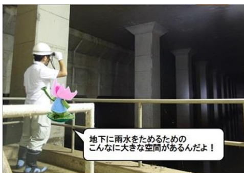
貯留施設（手賀の杜みはらしの広場）
