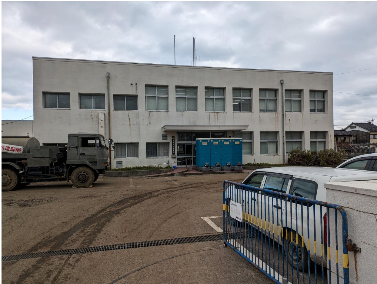
輪島市上下水道局庁舎
