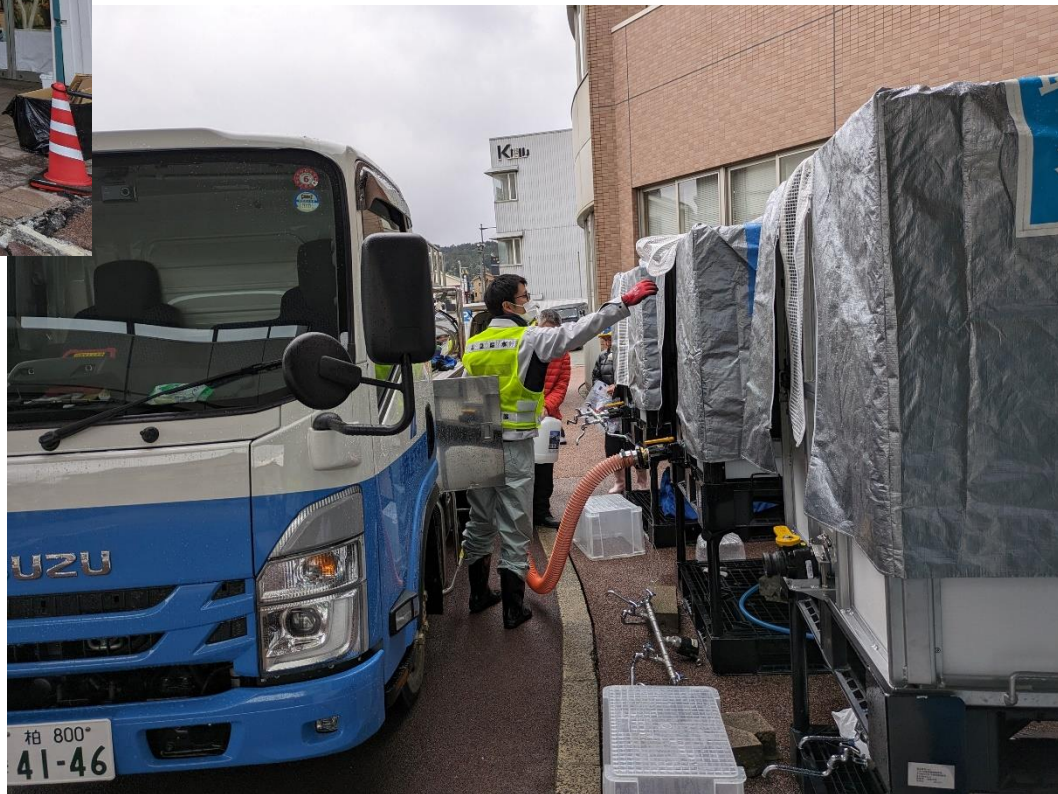
給水タンクへの補充作業の様子
