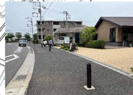
柏市道21140号線歩道部
