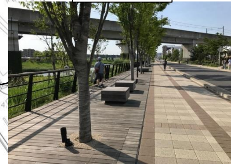
柏市道21139号線歩道部 (ウッドデッキ部分)
