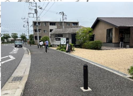
柏市道21140号線歩道部
