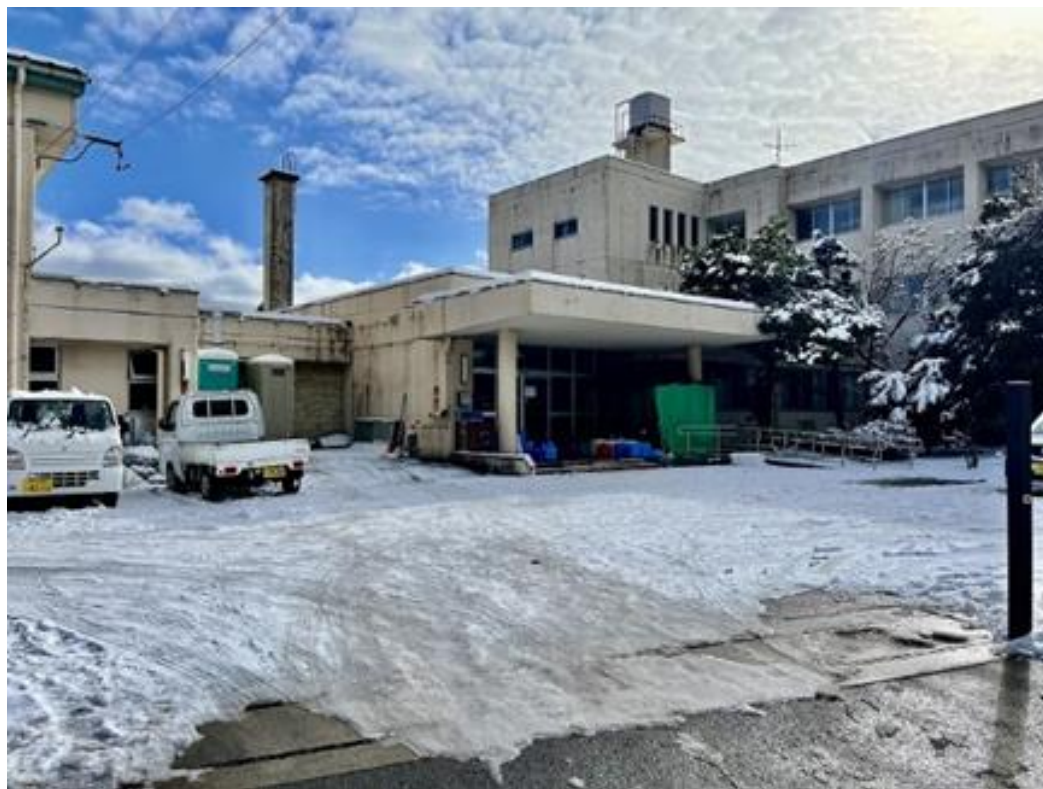
写真1：旧本小学校（避難所）
