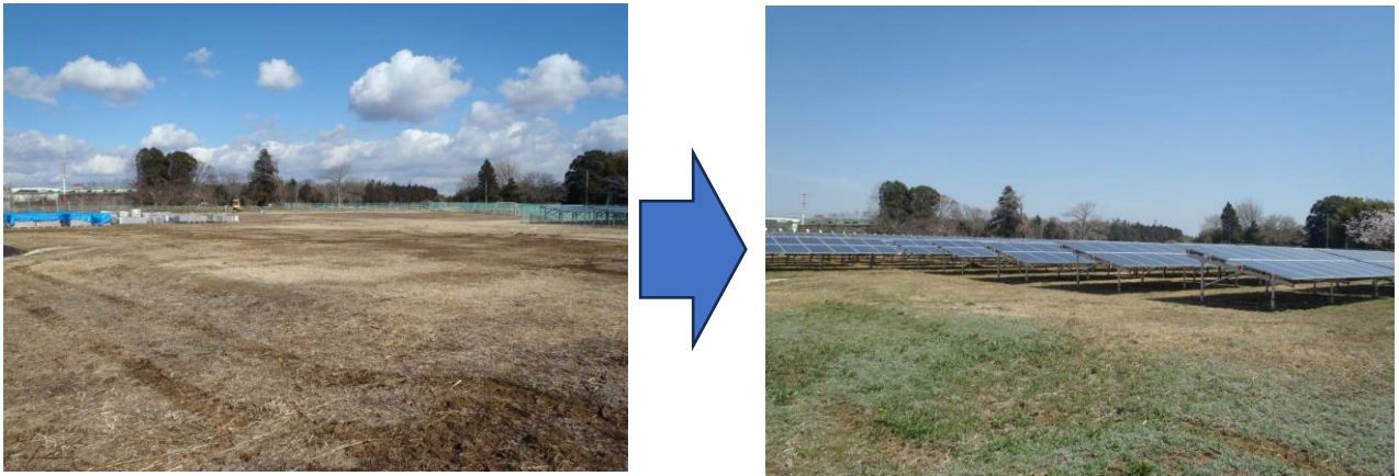
図3-4-1 未利用地への設置（柏市高柳ソーラー発電所）
