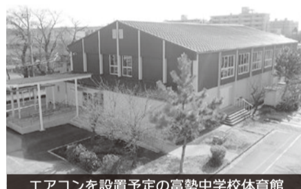
エアコンを設置予定の富勢中学校体育館
