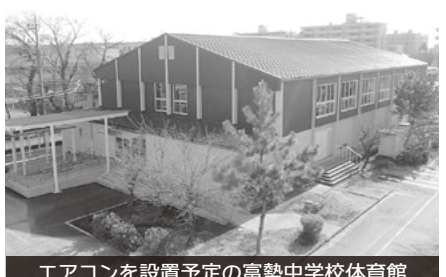
エアコンを設置予定の富勢中学校体育館
