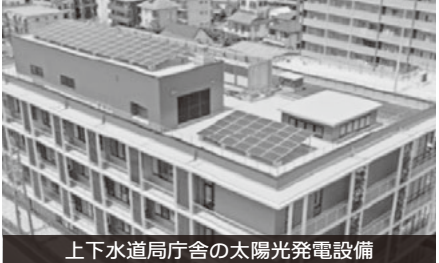
上下水道局庁舎の太陽光発電設備
