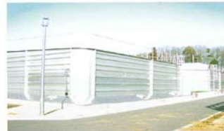
配水池（緊急貯水槽）
