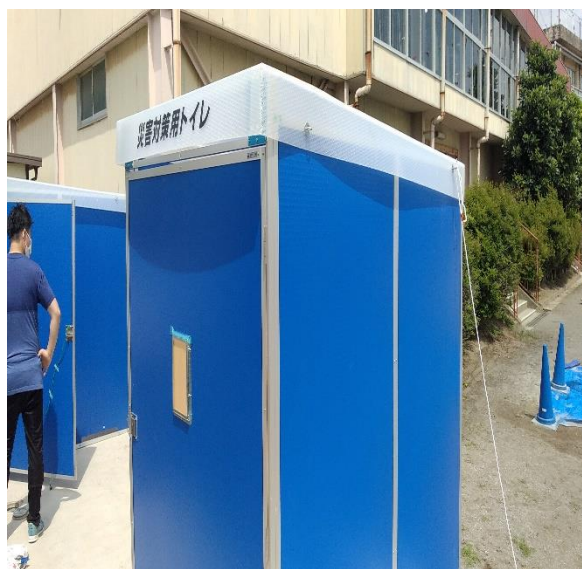
マンホールトイレの外観
