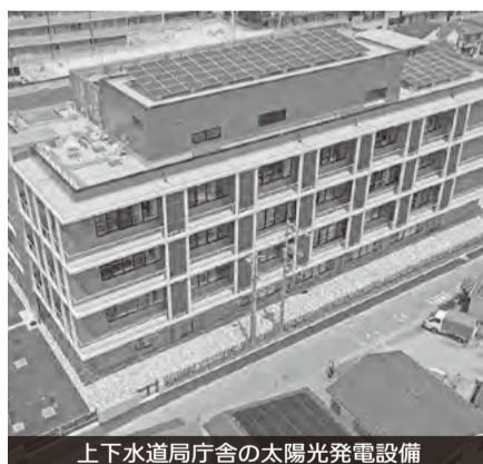
上下水道局庁舎の太陽光発電設備
