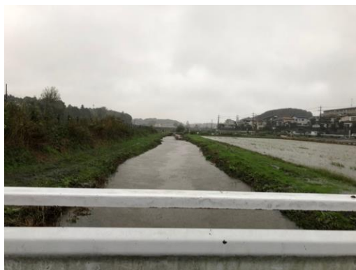
大津川支流左岸雨水6号幹線(藤心)
