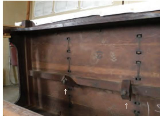
厚板間はボルトで継がれる。切断された斜材端部が残る
