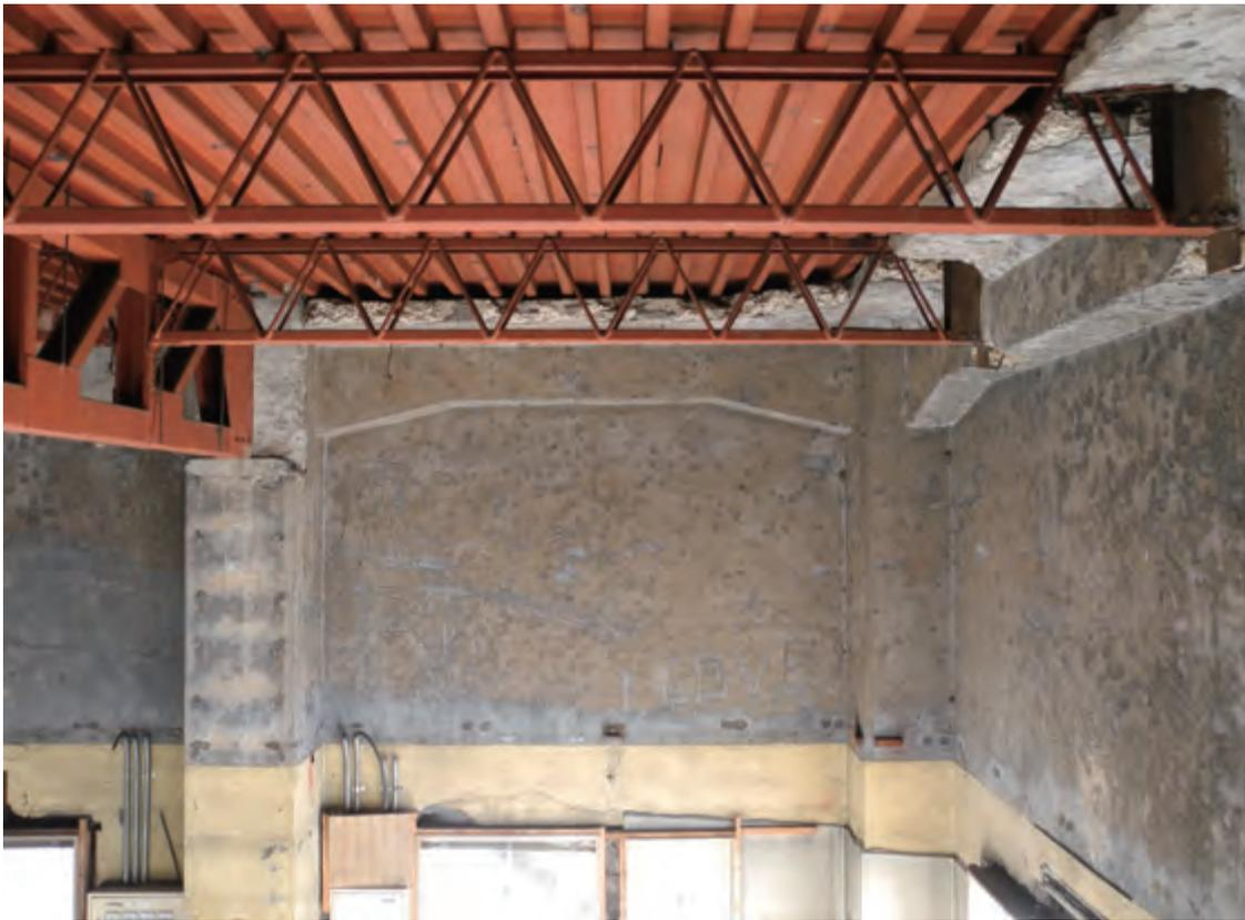
東面の壁 2階を設ける時に鉄骨梁を取り付けた位置では柱の表面がはつられたために、柱上方の梯子の取り付け痕は失われている。
