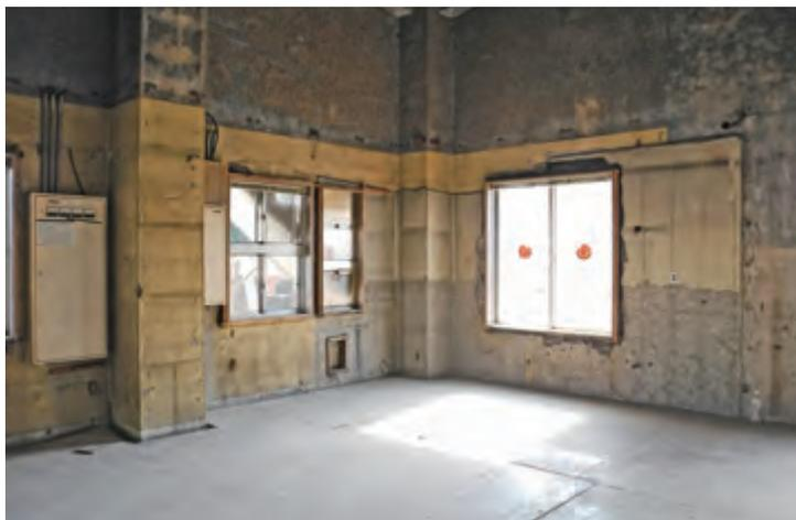
1 階室内南東隅 内装材を撤去すると、消防署に最初に改装された当時の壁仕上げが表れた。写真は風呂場と洗面所。この黄色の仕上げは、外壁仕上げの下に残る黄色い仕上げと時代が揃うと思われる。
