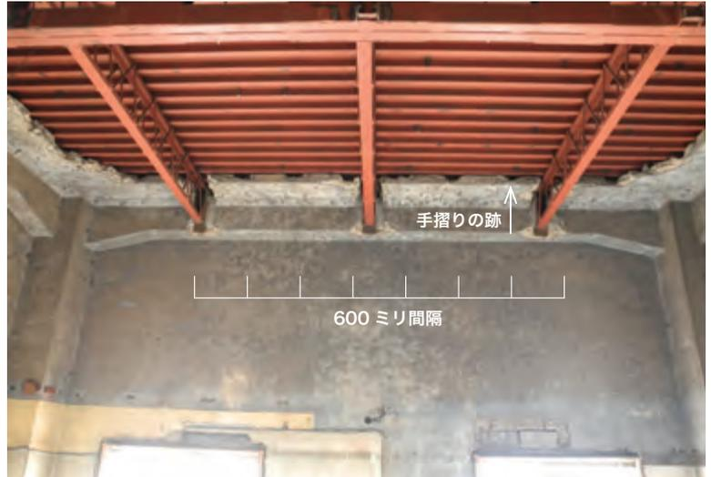
南面の壁を見上げる 回廊の幅、手摺り子が600ミリ間隔で立っていたことがわかる。回廊縁の厚さは120ミリ。
