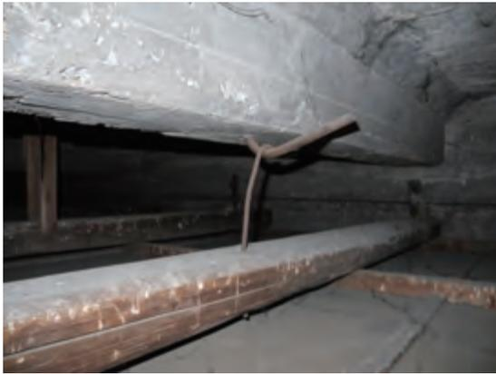
小梁下に突出する鉄筋に野縁受けが取り付けく。
