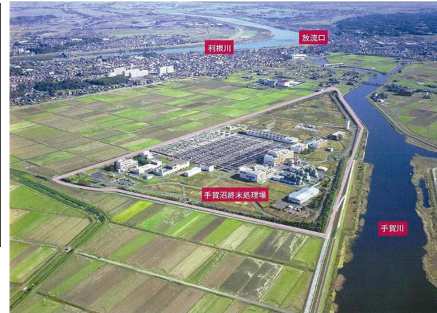
手賀沼終末処理場 全景写真
