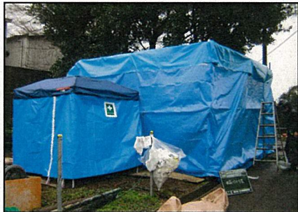
除染作業場所となる仮設ハウス及び汚染検査場所
