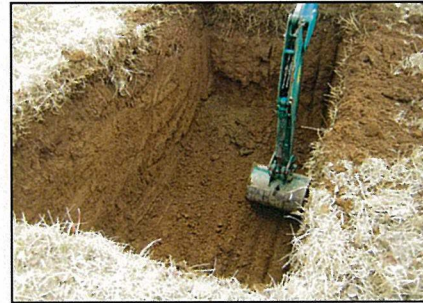
地下保管場所の掘削
