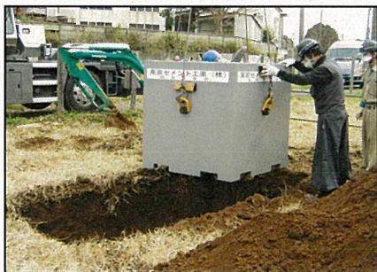
大型クレーンでコンクリート容器を埋設
