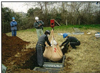
汚染土壌をコンクリート容器へ詰め込み
