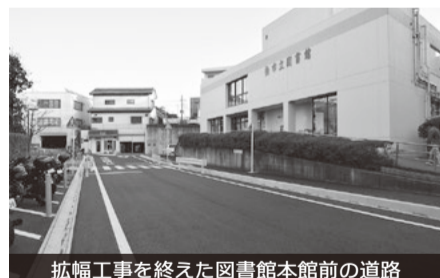
拡幅工事を終えた図書館本館前の道路
