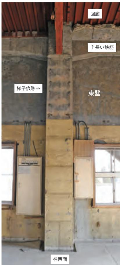
柏市による3Dレーザー測量実施のために天井を解体、回廊と梯子の痕跡が明らかになる。
