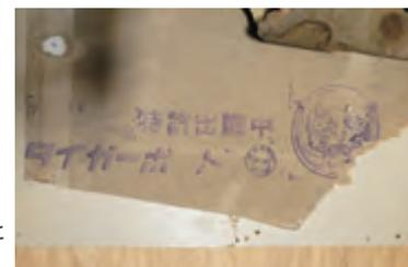
天井に張られた吉野石膏製板材裏面のロゴと「特許出願中 タイガーボード」の文字
