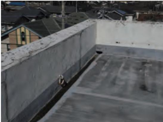
屋上 排水溝隅部から雨樋に雨水が落ちる
