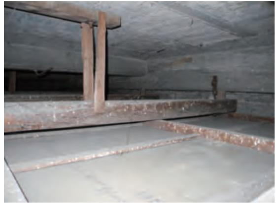
小梁のない位置では、天井に受け材をボルト締め、吊り木で野縁受けを吊る。野縁受け先端は大梁にボルト締め
