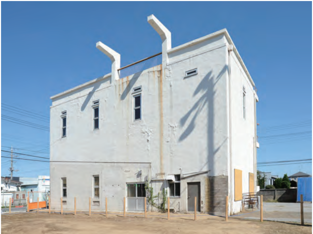
測遠器訓練所 起重機で屋上に測遠機をあげて、遠方の航空機や高い構造物の位置を測定する訓練をした。写真 小林正孝 西面全景 屋上には起重機支柱が立ち、壁面に起重機昇降レール支持材の取り付けいた痕跡が残る。 隣地の消防署別棟解体後、高野台町会集会所建設準備中（2015年春撮影）
