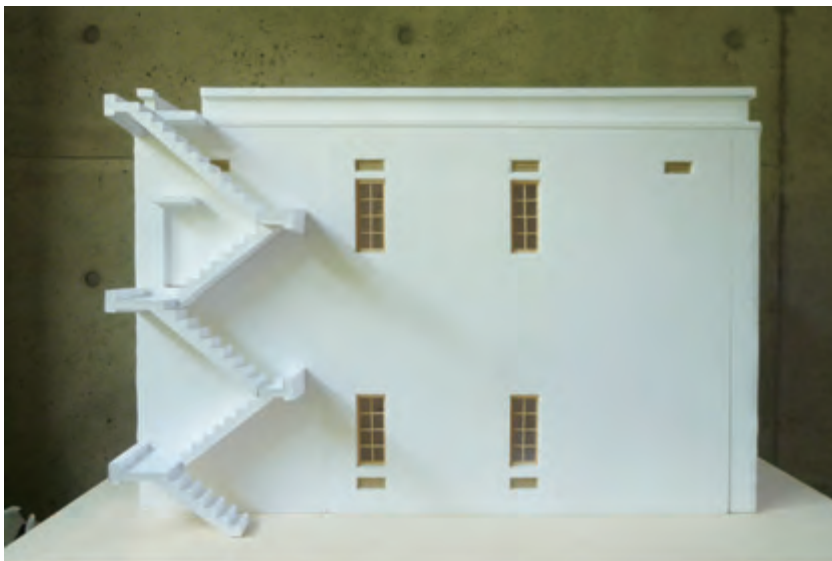
高射砲第2連隊照空予習室 復原模型 上階（当初は回廊）及び屋上へは外階段である
