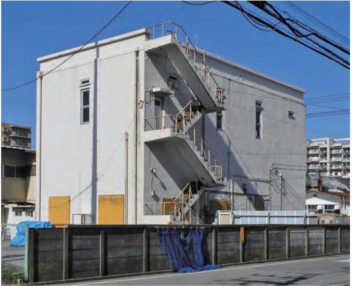
外観 背側面 南東から見る
