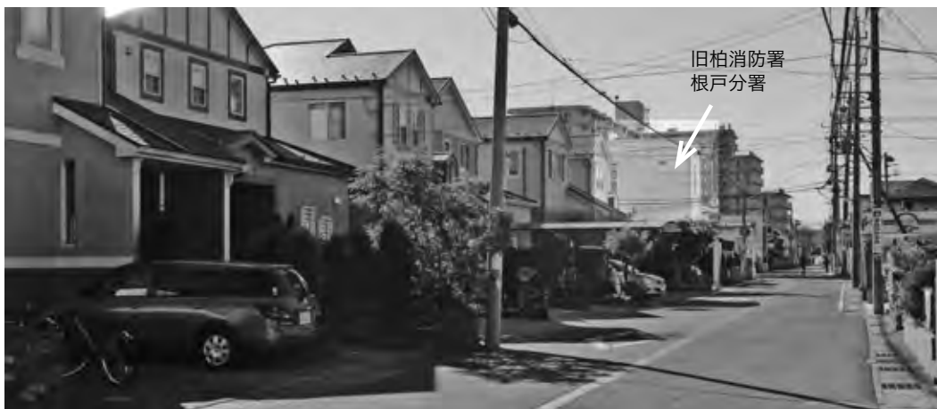
旧根戸分署を東から見る 分署のある住宅街は、高射砲第2連隊跡地に形成された
