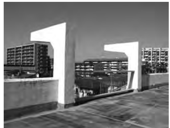
屋上西面にはクレーン支柱が立つ
