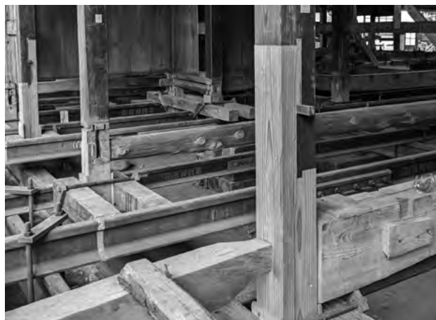
図 3-2-12 木工事 柱根継 (尻挟み継)
