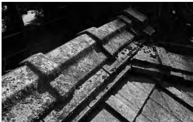
図 7-3-9 風呂場 セメント瓦（冠瓦）
