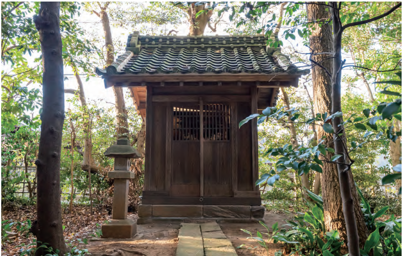
35. 稲荷社覆屋 竣工 東面
