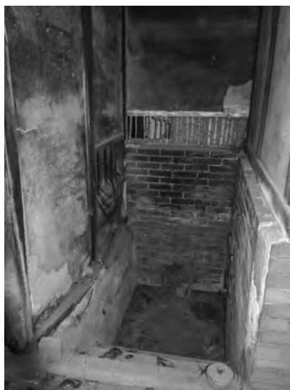
87. 風呂場 修理前 焚口
