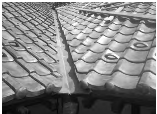
図 3-2-24 屋根工事 谷 (修理後)
