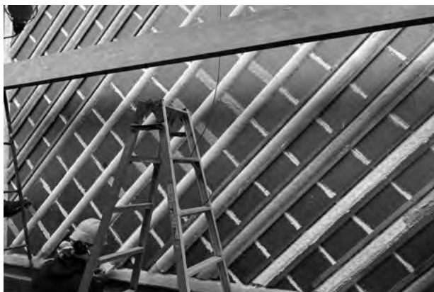
図 4-2-8 前蔵 左官工事 北面 なまこ壁
