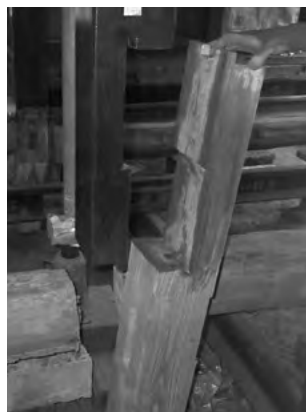
図 3-2-13 木工事 柱根継 (既存尻挟み継取替)
