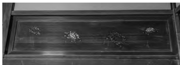
図 3-5-16 旧吉田家住宅新座敷 欄間
