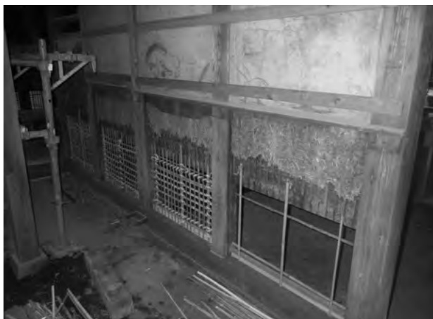
図 3-2-25 左官工事 外壁 小舞の補修
