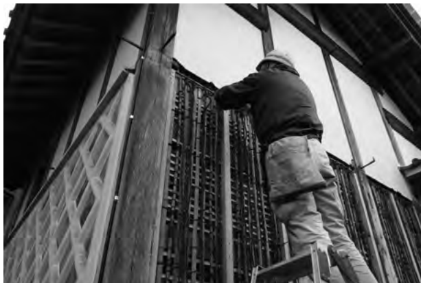
図 4-2-6 前蔵 左官工事 北面 なまこ壁下土壁
