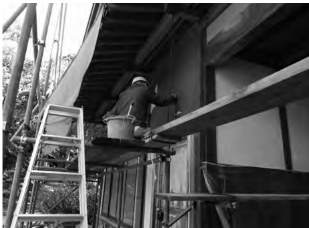
図 5-2-2 長屋門 左官工事 外壁鼠漆喰仕上
