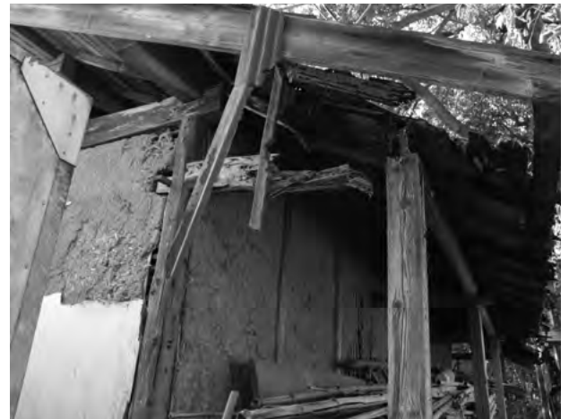
図 7-1-15 肥料小屋 背面（北面）下屋
