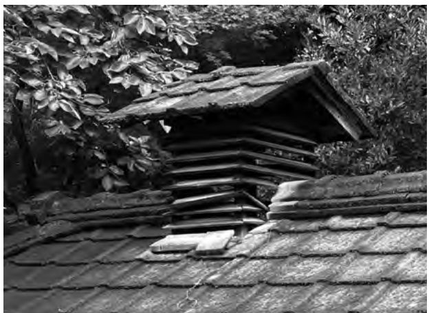
85. 風呂場 修理前 煙出し
