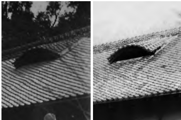
図 3-5-5 古写真の煙出し 明治期
