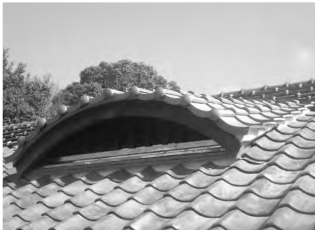
図 3-2-23 屋根工事 煙出し (完成)
