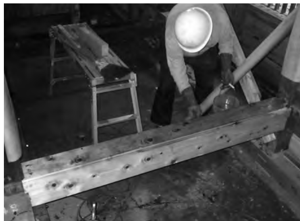
図 3-2-15 木工事 防腐・防蟻剤処理 (足固)
