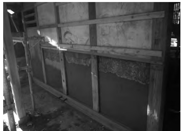
図 3-2-26 左官工事 外壁 土壁
