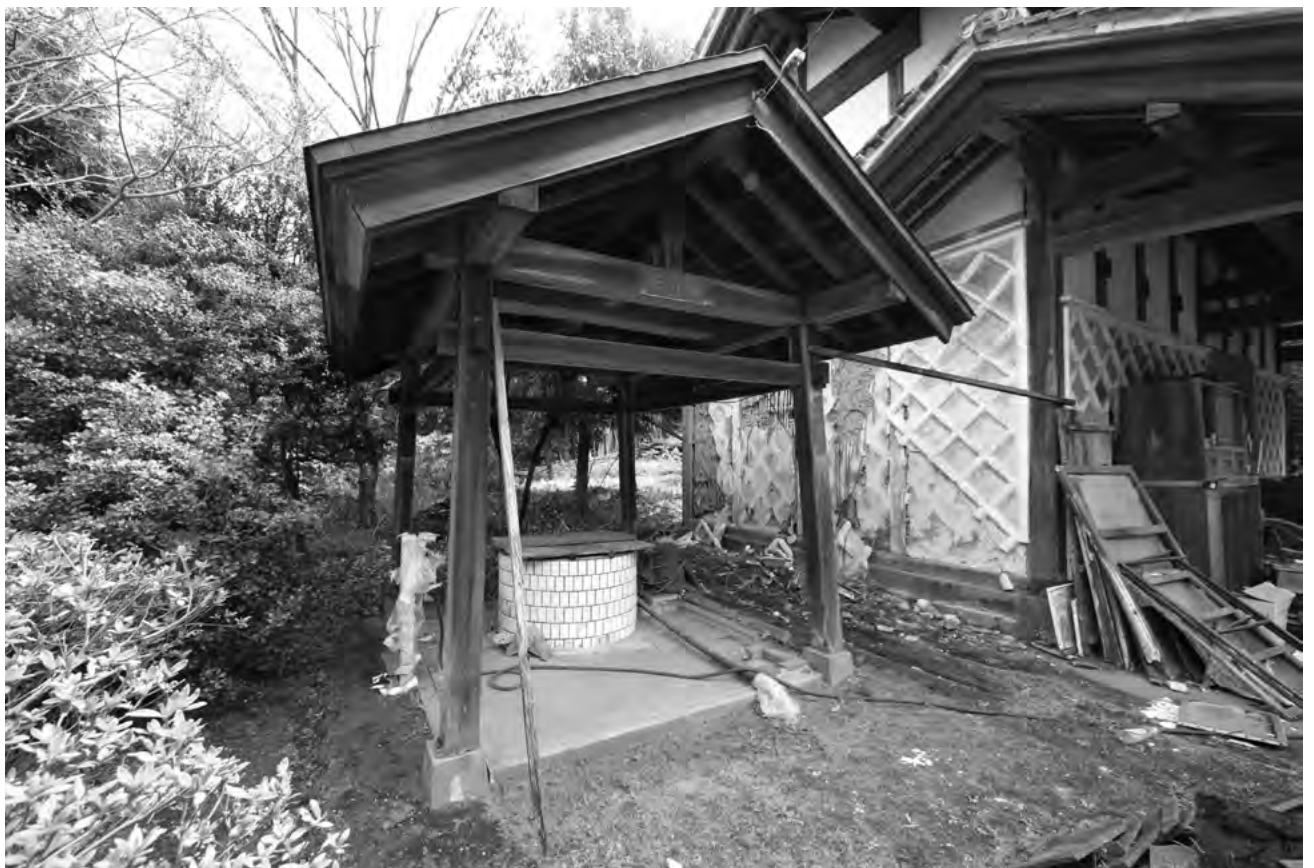
82. 井戸屋形 修理前 西面
