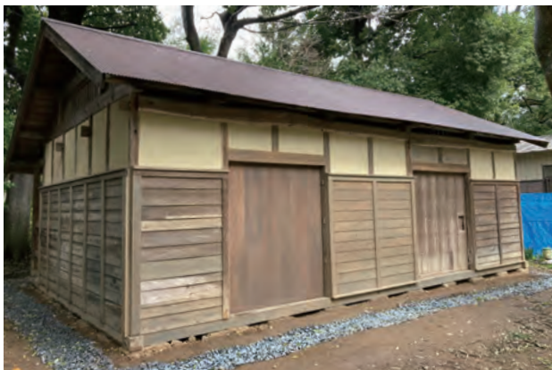
10. 肥料小屋 竣工
