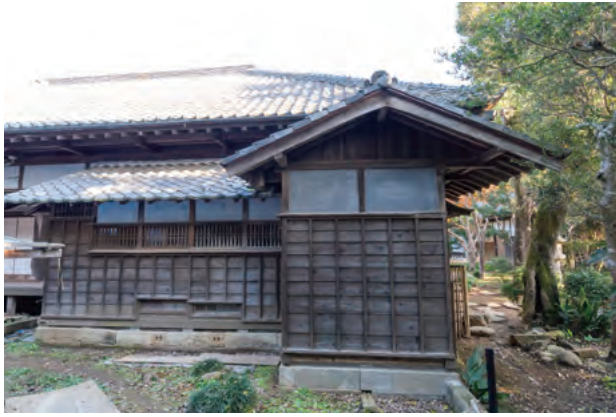
3. 主屋 竣工 西面便所
