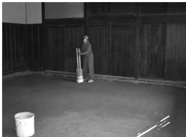
図3-2-27 左官工事 土間三和土
