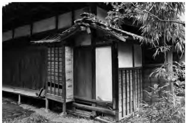
図 3-1-15 南東 旧渡り廊下接続部
