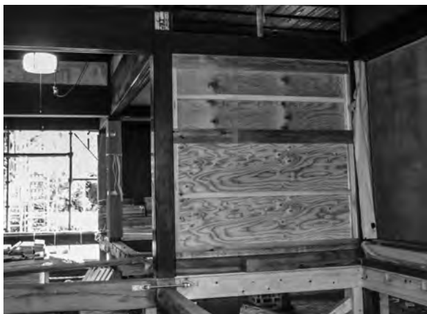
図 3-3-7 構造用合板補強壁 [つ十五～十七] 西から見る
