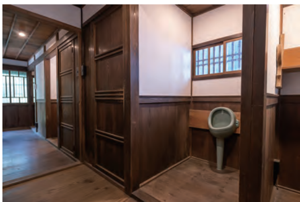
25. 主屋 竣工 便所
