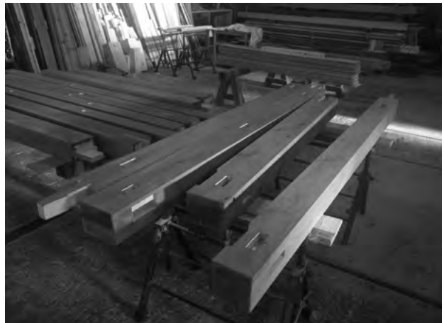
図 3-2-10 木工事 土台（新規材）
