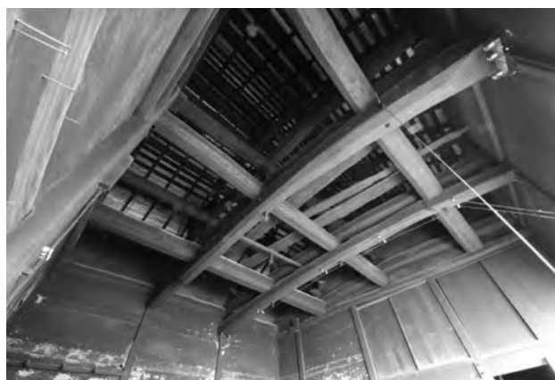
図 3-4-9 小屋組 ドマ東（修理前）
