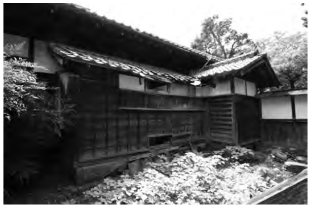
図 3-1-14 便所下屋 西面
