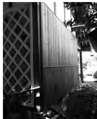
図 4-1-6 前蔵 北側壁面 仮設板壁による養生
