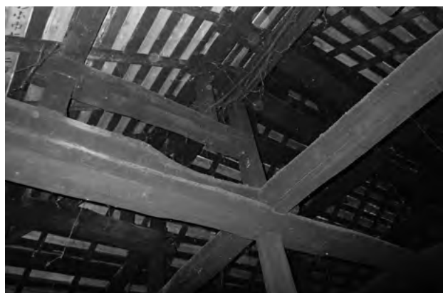
図 3-4-10 小屋組 〔つ二十一〕（修理前）
