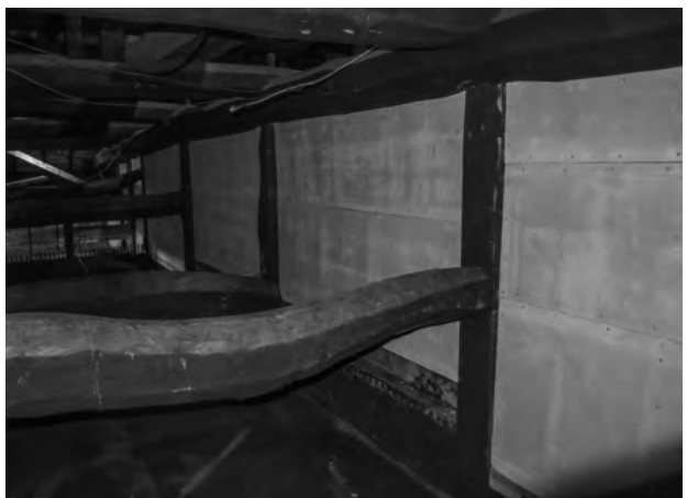
図 3-3-8 荒壁パネル補強壁 [つ通り] 天井より上の小壁
