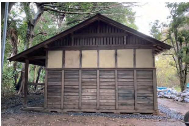
45. 肥料小屋 竣工 西面
