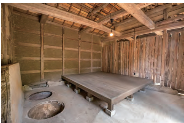
47. 肥料小屋 竣工 西室内観
