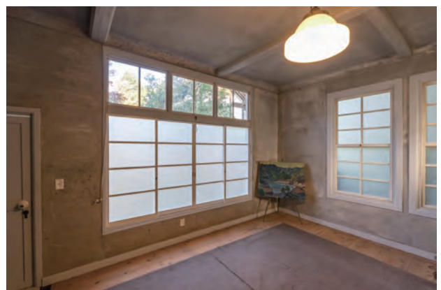
32. 長屋門 竣工 東室内観
