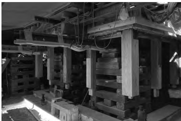
図 6-2-9 文庫蔵 木工事 柱修理完了
