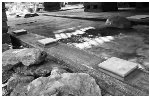
図 3-2-7 基礎・石工事 ネコ石
