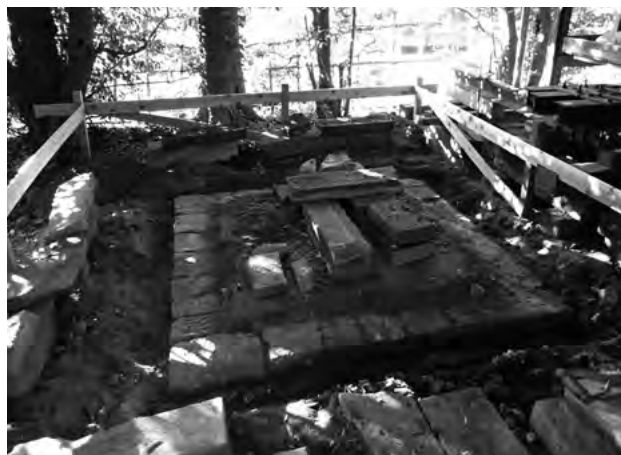
図7-2-2 稲荷社 石工事 上段解体
