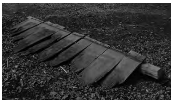
図 3-5-10 式台玄関 修理前板
