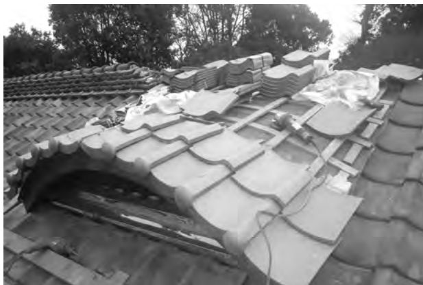
図 3-2-22 屋根工事 煙出し
