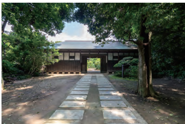
31. 長屋門 竣工 南面及び敷石
