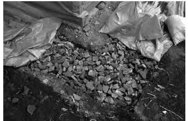
図 7-2-32 肥料小屋 外構工事 古瓦
