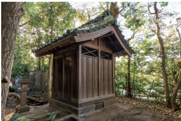
36. 稲荷社覆屋 竣工 北東面
