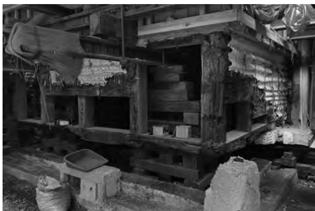
図 6-2-7 文庫蔵 木工事 柱の修理前
