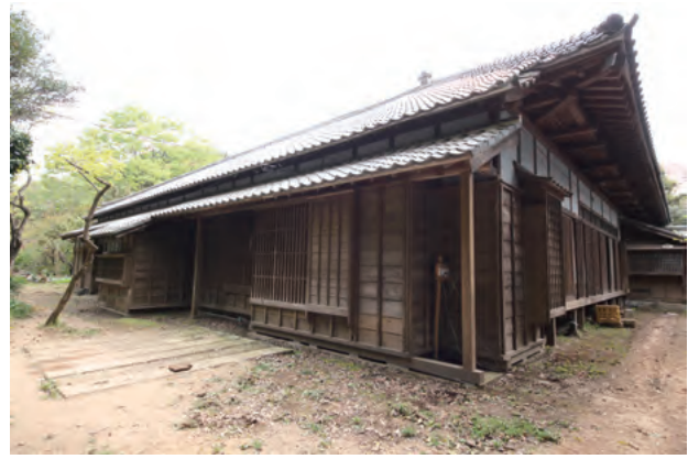
4. 主屋 竣工 北面
