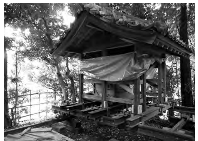
図7-2-1 稲荷社 揚家工事 曳家後
