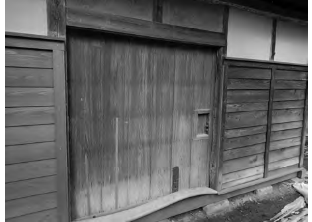
図 7-2-31 肥料小屋 建具工事 東室建具
