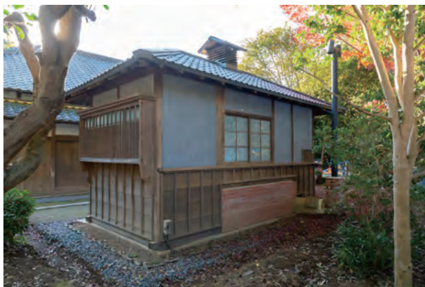
39. 風呂場 竣工 北面
