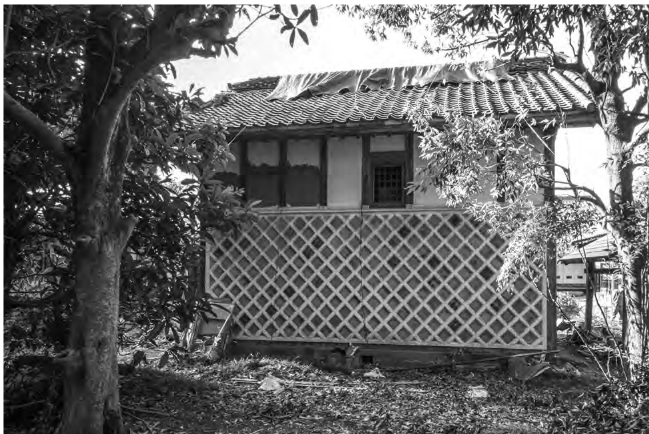
76. 前蔵 修理前 東面
