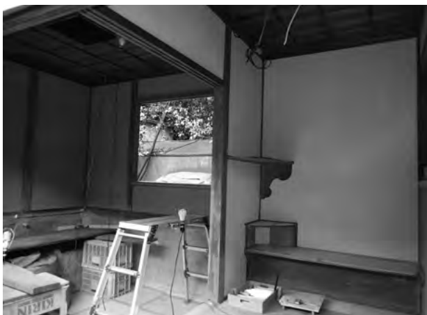
図 7-2-17 風呂場 左官工事 内壁
