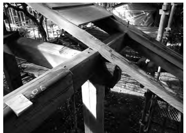
図 7-2-26 肥料小屋 木工事 横架材
