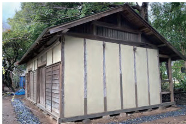
46. 肥料小屋 竣工 東面
