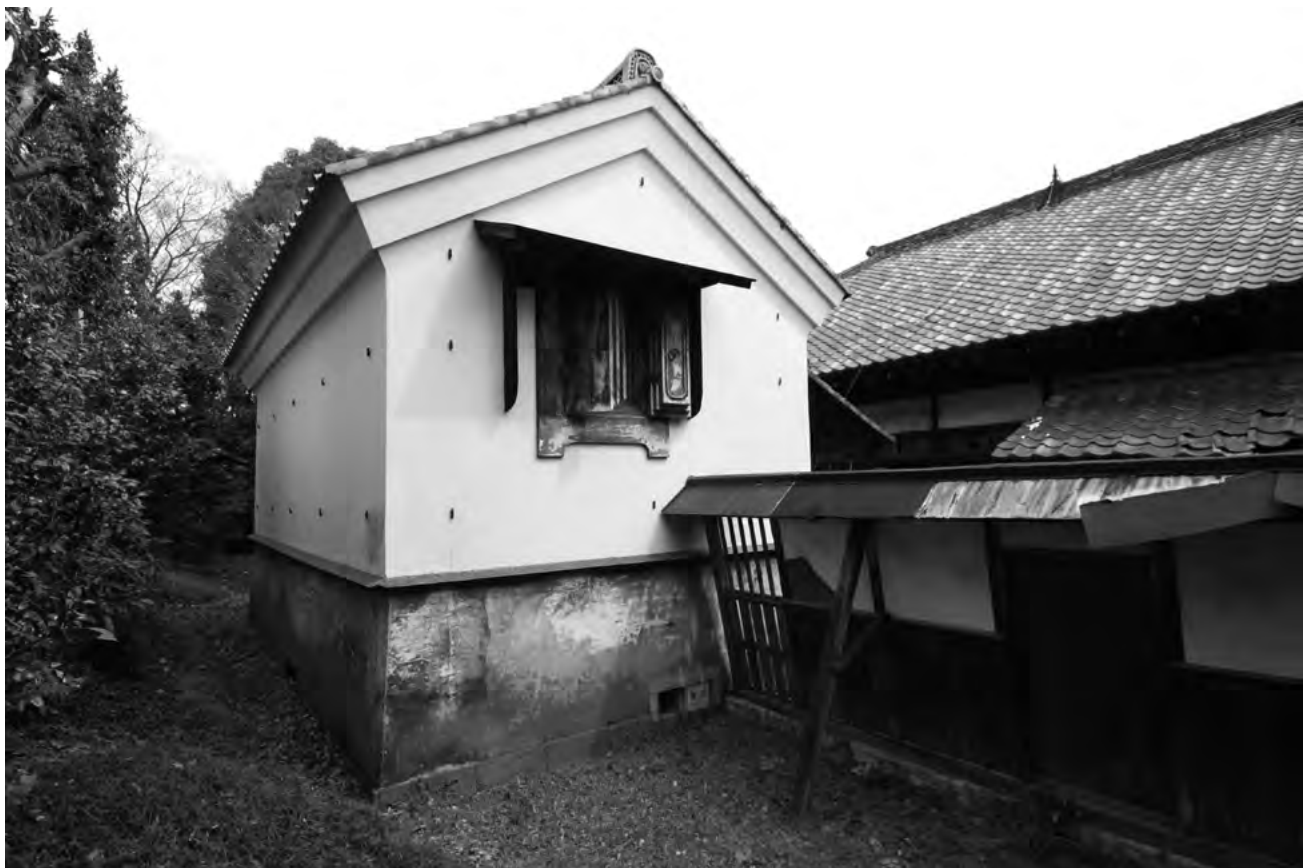
80. 文庫蔵 修理前 南面
