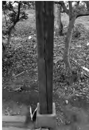
図 7-2-34 井戸屋形 木工事 柱根継 (北東)
