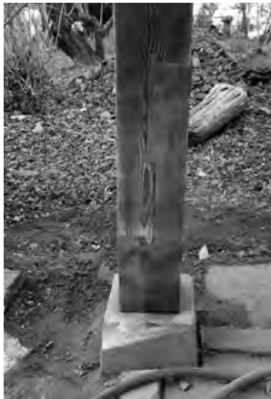
図 7-2-33 井戸屋形 木工事 柱根継 (北西)
