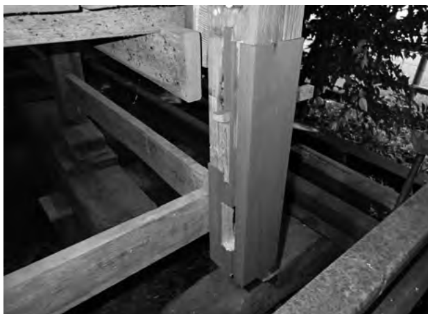
図 7-2-4 稲荷社 木工事 柱根継
