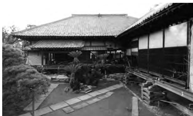
図 3-2-5 揚家工事 揚げ
