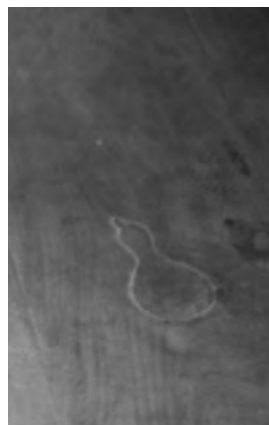
図 3-4-20 南縁 縁板埋木 (補強箇所のため別途保管)
