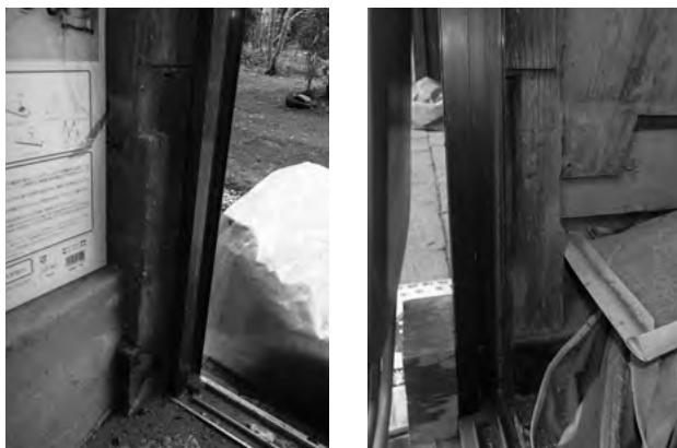
図 5-2-7 長屋門 木工事 西室北面戸の柱痕跡 左：西, 右：東
