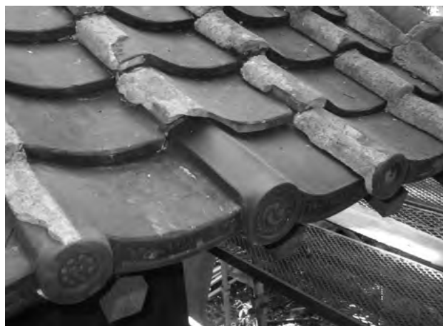
図 7-2-6 稲荷社 屋根工事 軒瓦の取替え
