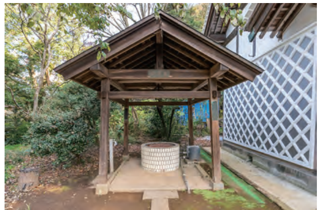
11. 井戸屋形 竣工
