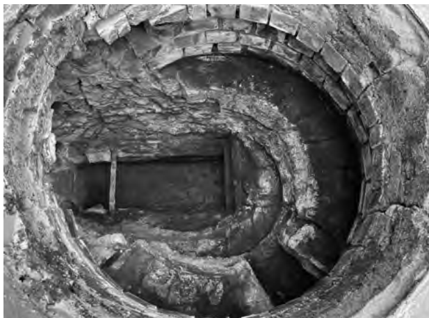
図 7-3-4 風呂釜 枠 (風呂釜、ロストル解体時)
