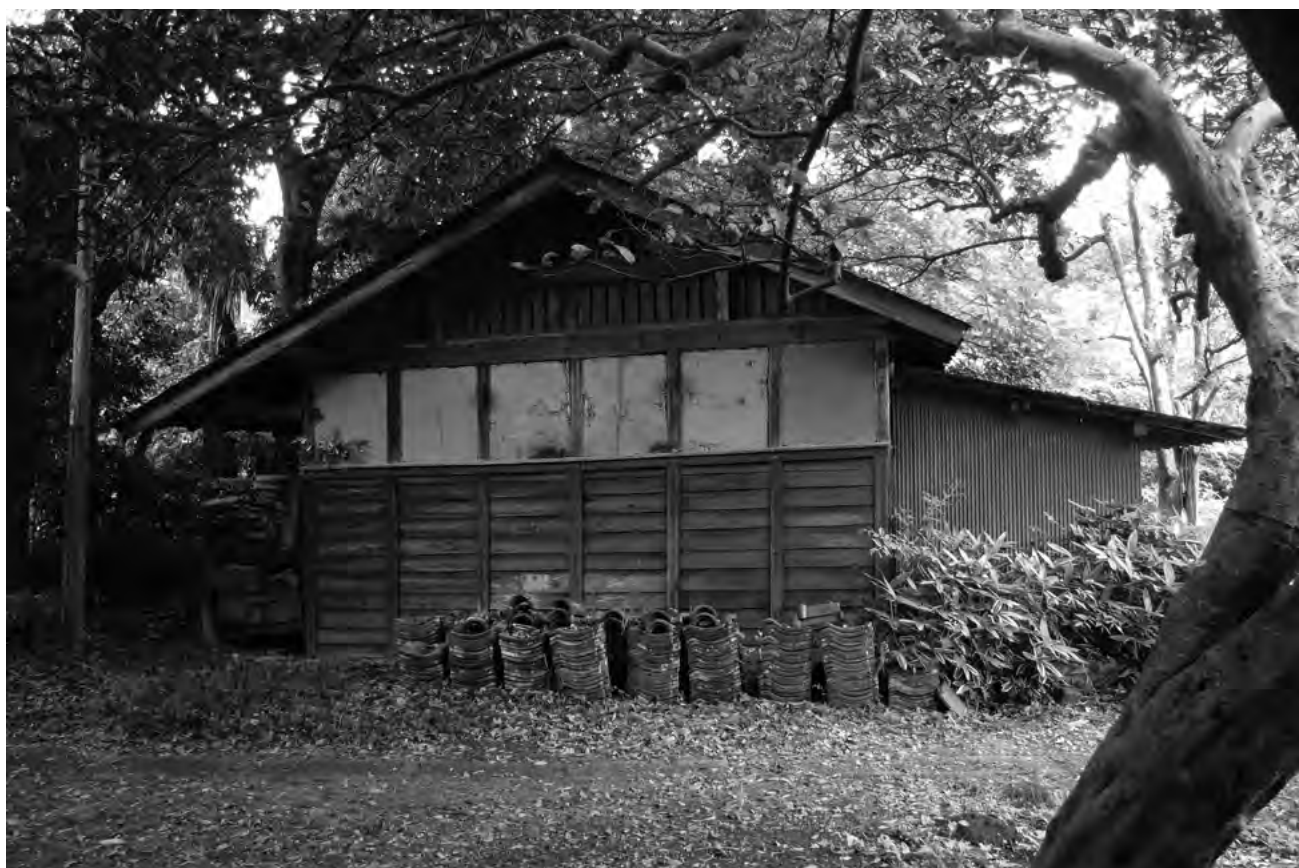
90. 肥料小屋 修理前 西面
