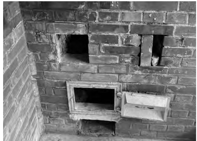
図 7-2-18 風呂場 左官工事 焚口煉瓦積
