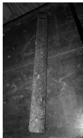
図 5-3-2 長屋門 上げ下げ窓 分銅
