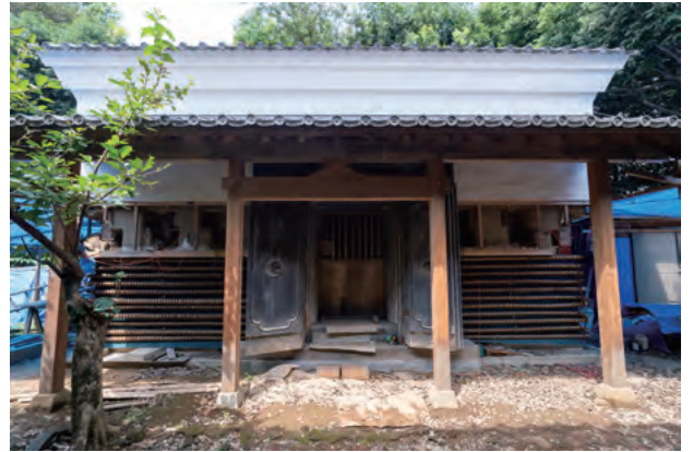
7. 文庫蔵 (工事中)
