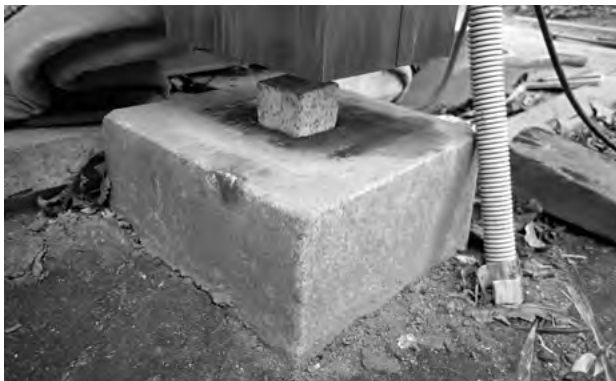
図 7-2-35 井戸屋形 石工事 石ダボ
