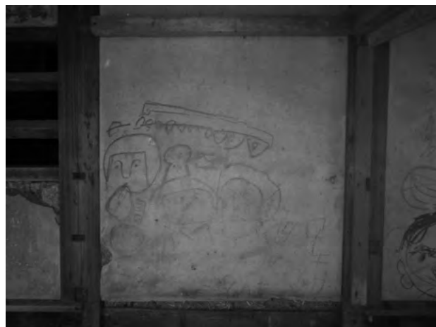
図 3-4-22 北面壁 落書きは昭和中期頃
