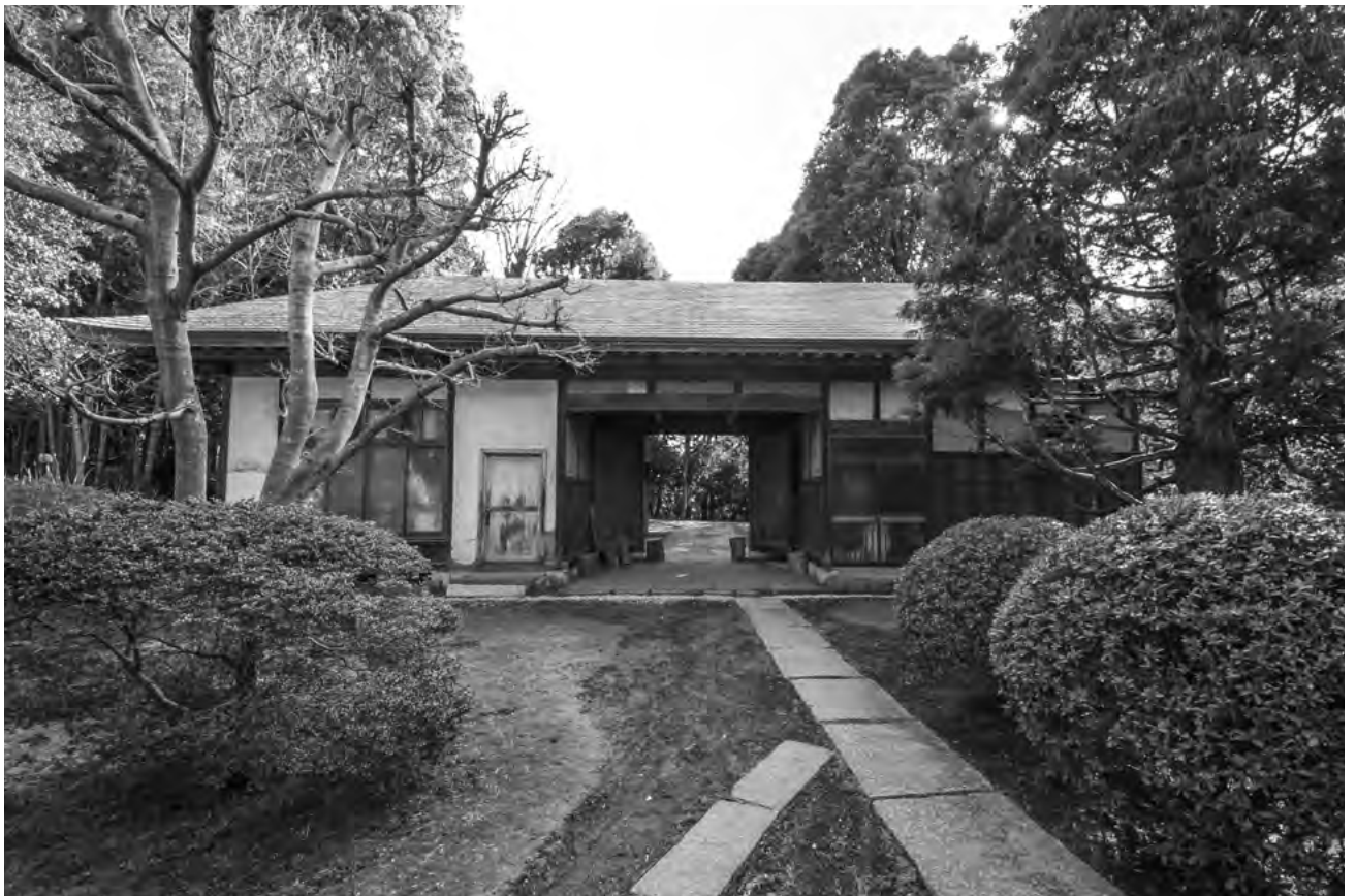
78. 長屋門 修理前 北面
