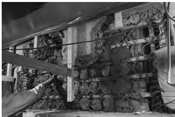
図 6-2-12 文庫蔵 左官工事 杉小舞修理後の荒壁付け
