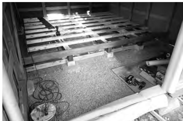
図 7-2-28 肥料小屋 木工事 内部床組
