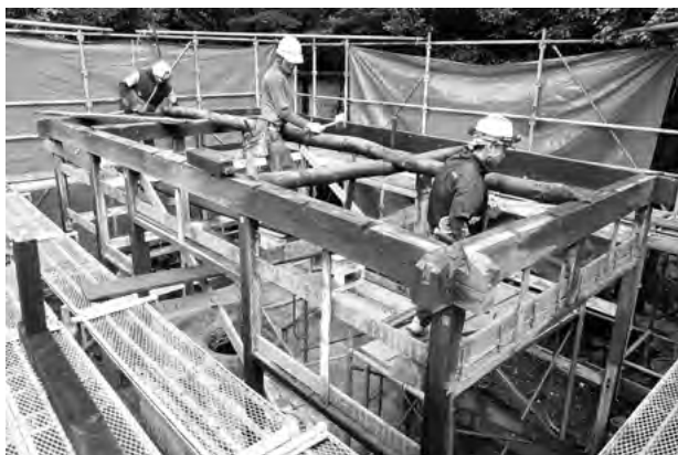
図 7-2-9 風呂場 解体工事 軸部解体
