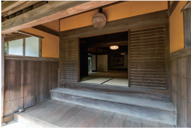
10. 主屋 竣工 式台玄関
