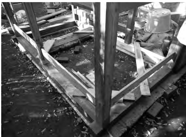
図 7-2-12 風呂場 木工事 柱
