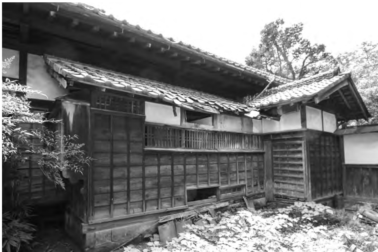
64. 主屋 修理前 西面便所
