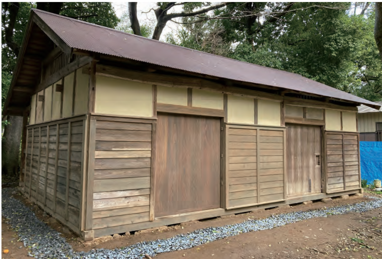
44. 肥料小屋 竣工 南面
