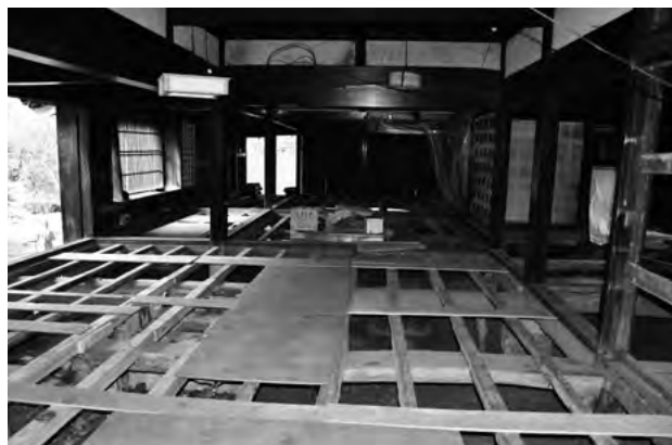
図 3-2-3 解体工事 床・床組
