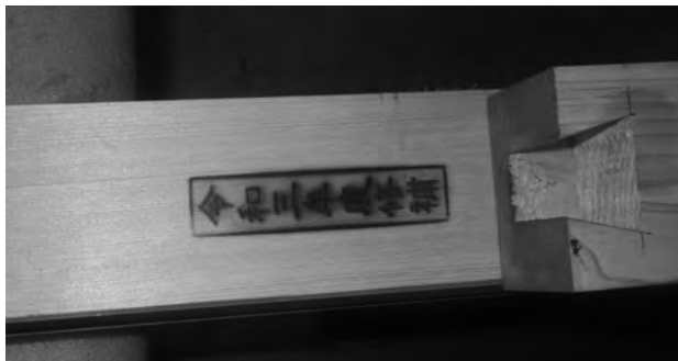
図 3-2-8 木工事 新規補足材の焼印
