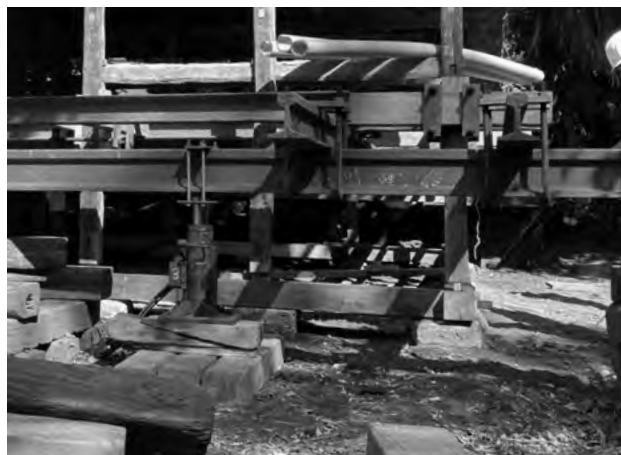
図 7-2-23 肥料小屋 揚家工事 降し
