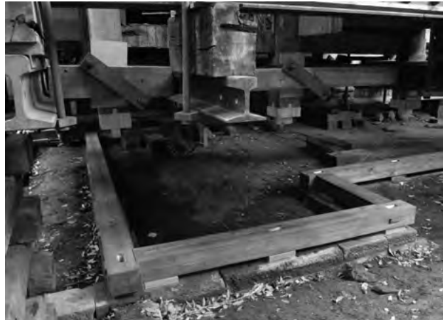
図 3-2-11 木工事 土台（新規材）
