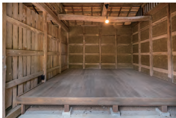
48. 肥料小屋 竣工 東室内観
