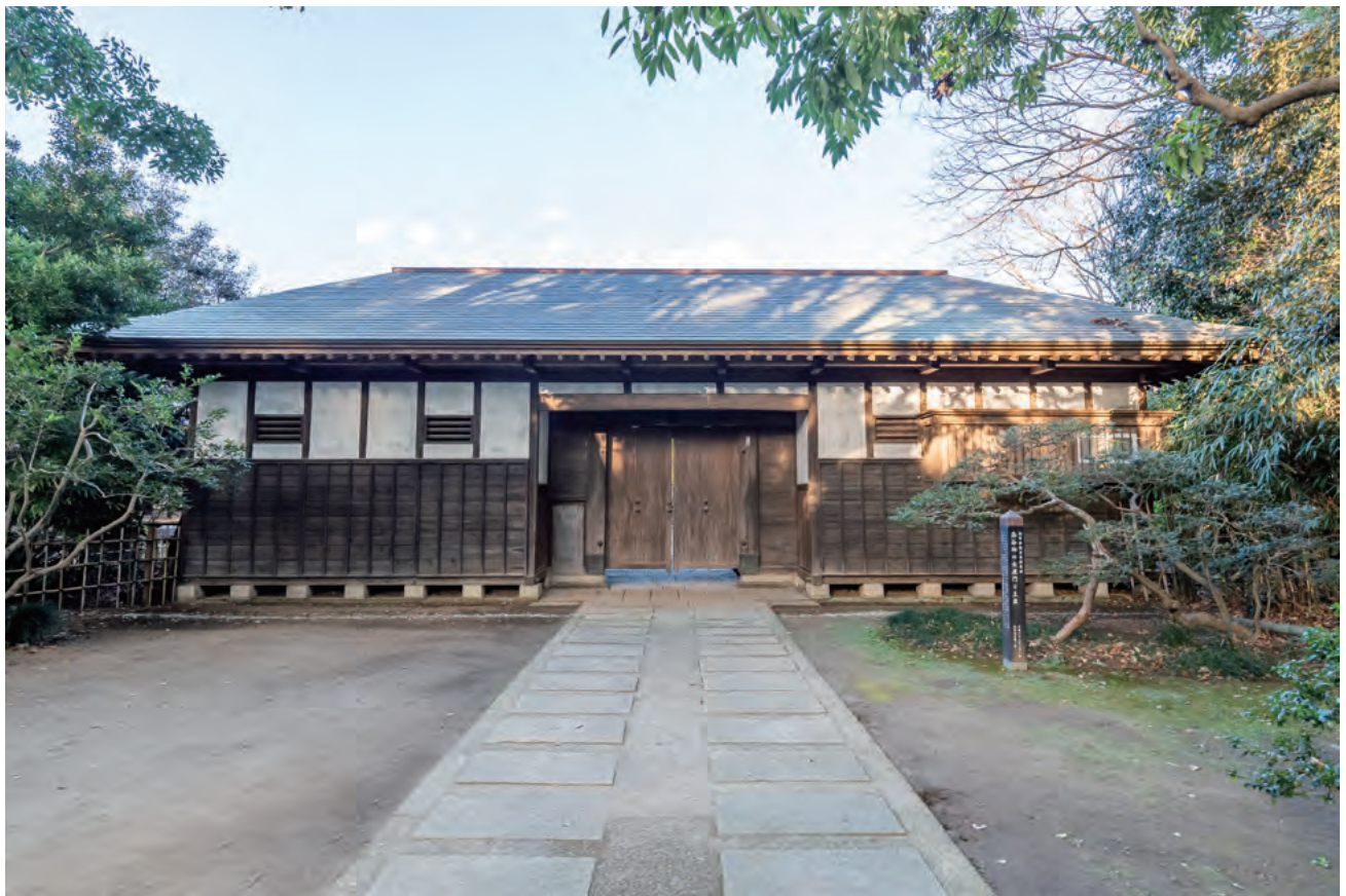
28. 長屋門 竣工 南面
