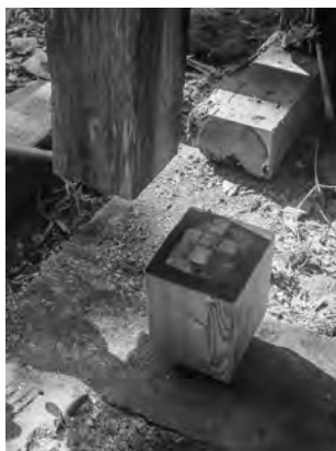
図 3-2-14 木工事 柱根継 (隠し十字目違継)
