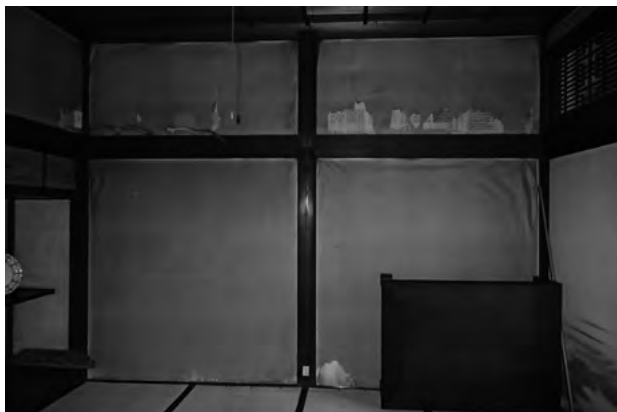
図 3-1-25 オクノマ 壁紙張の焼け、破れ
