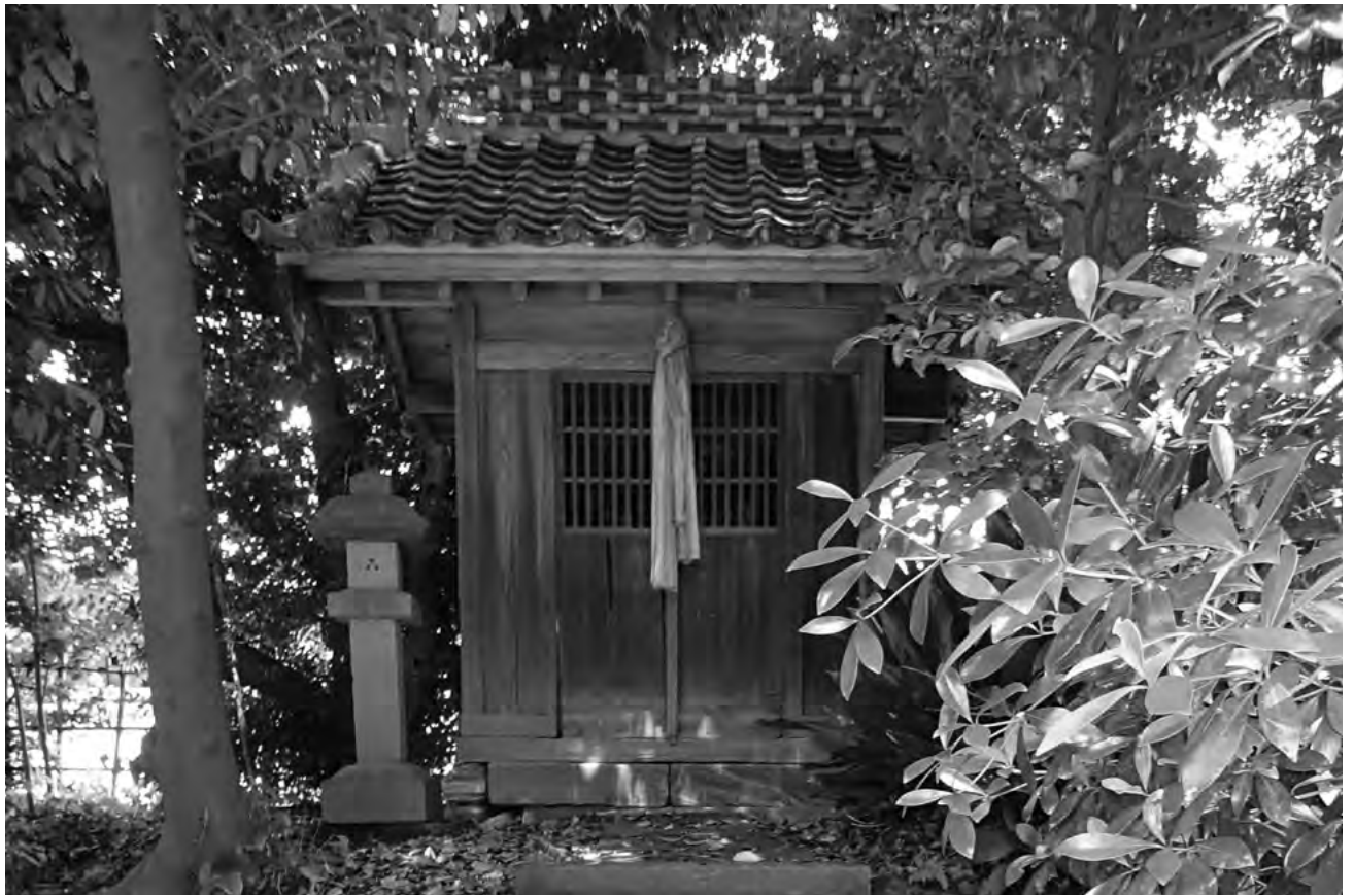
81. 稲荷社覆屋 修理前 東面
