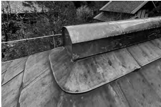
図 5-2-6 長屋門 板金工事 新規屋根棟の板金
