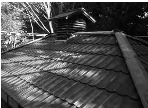
図 7-2-15 風呂場 屋根工事 板金屋根
