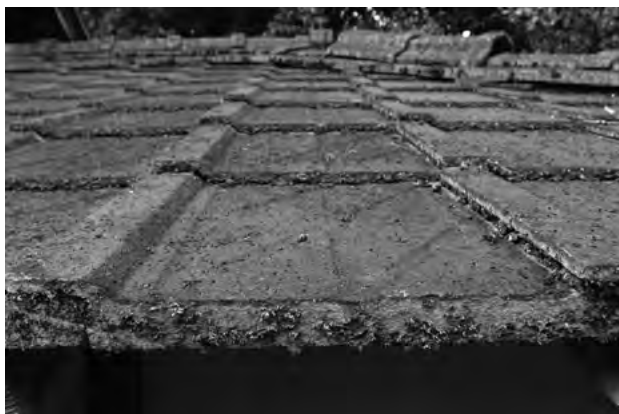
図 7-3-7 風呂場 セメント瓦（平瓦）
