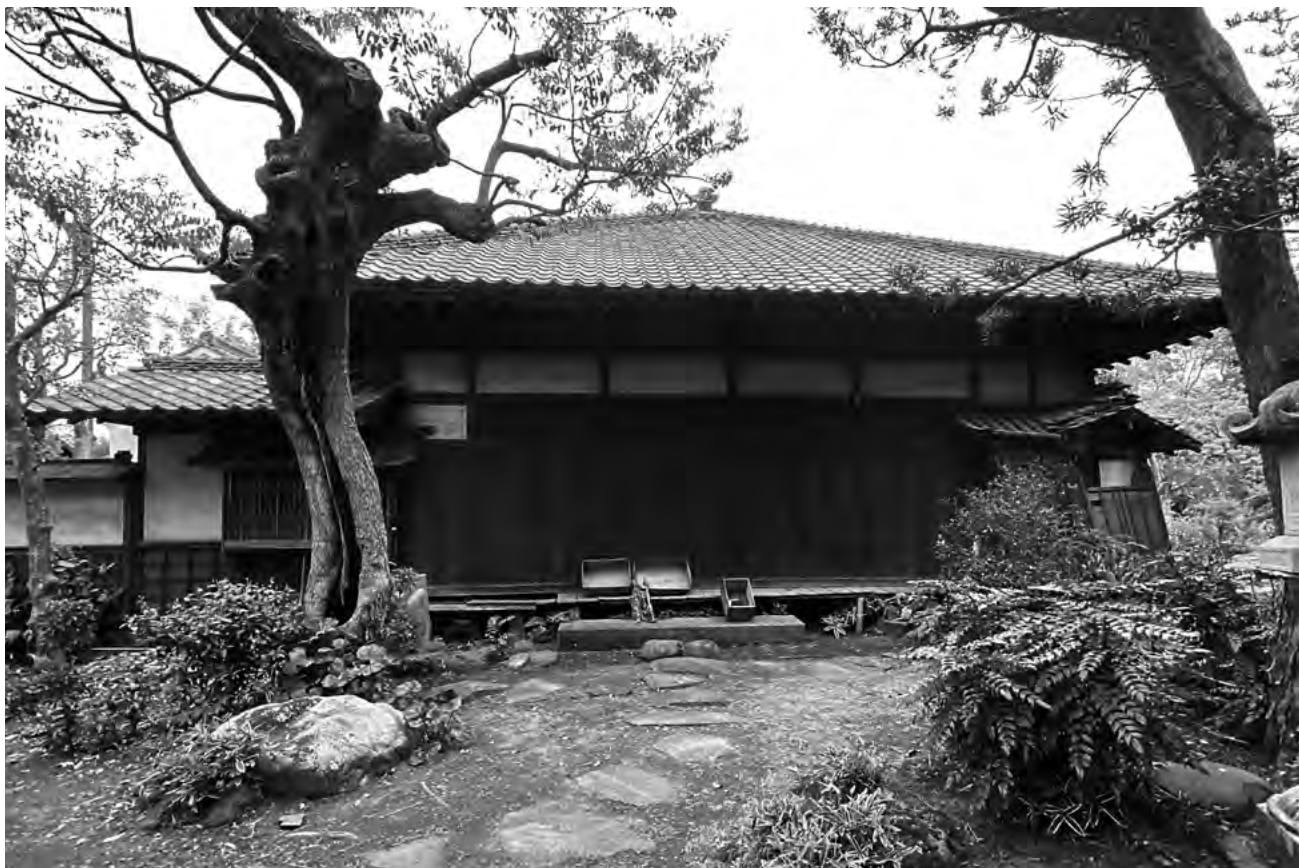
63. 主屋 修理前 南面
