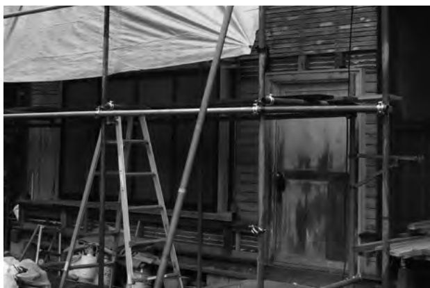
図 5-2-3 長屋門 木工事 東室 北面壁木摺下地修理中
