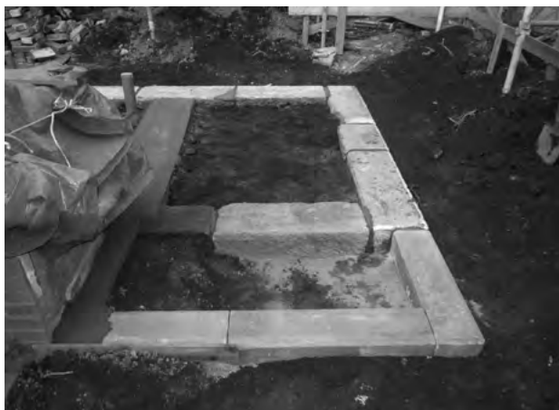
図 7-2-10 風呂場 石工事 基礎石
