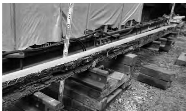
図 3-1-6 ドマ東面土台 下面 (解体時)
