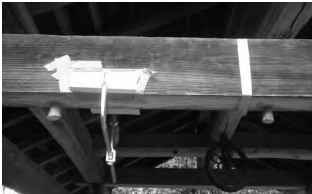
図 7-2-36 井戸屋形 木工事 貫の埋木補修
