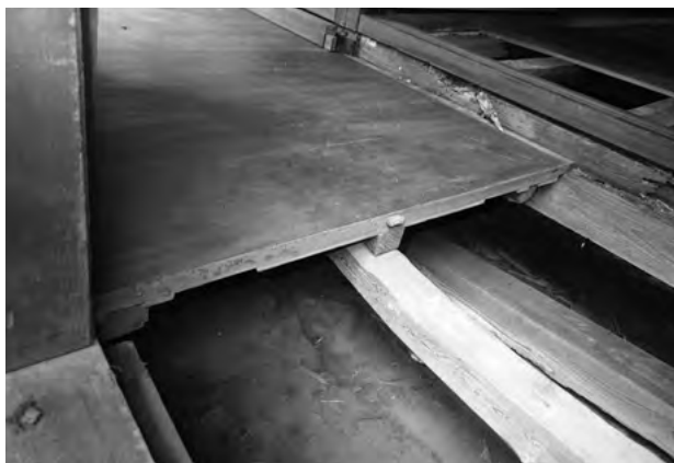
図 3-4-18 南縁 床板断面 (解体中)
