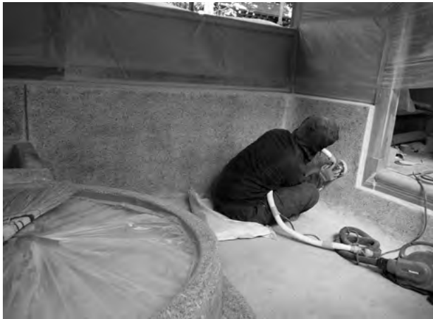
図 7-2-16 風呂場 左官工事 腰壁研ぎ出し仕上
