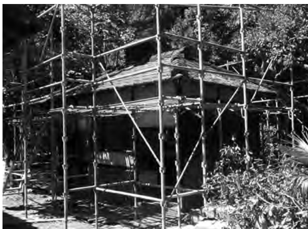
図 7-2-8 風呂場 仮設工事 外部足場
