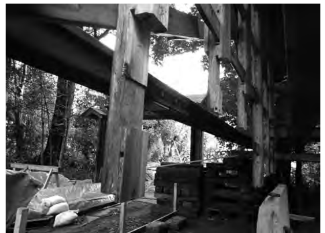
図 7-2-25 肥料小屋 木工事 柱
