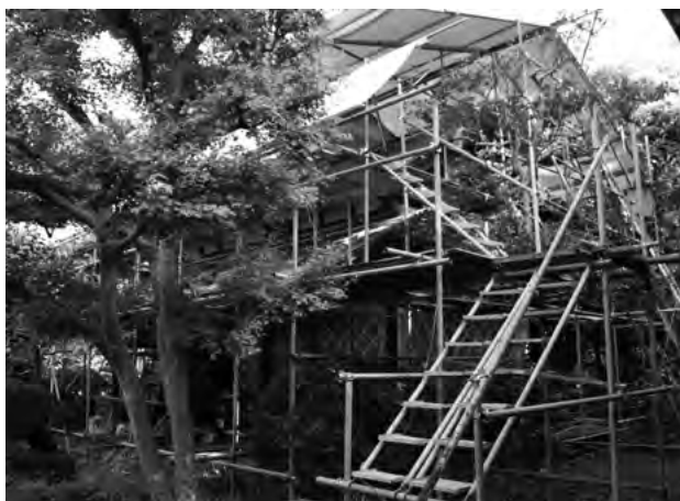
図 4-2-3 前蔵 仮設工事 足場
