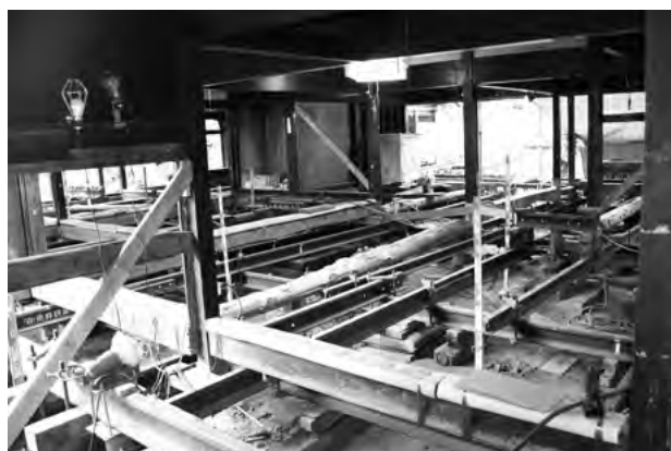
図 3-2-4 揚家工事 資材搬入・鋼材設置
