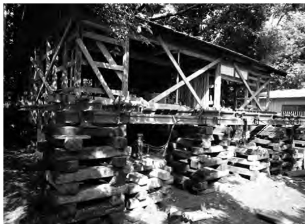
図 7-2-22 肥料小屋 揚家工事
