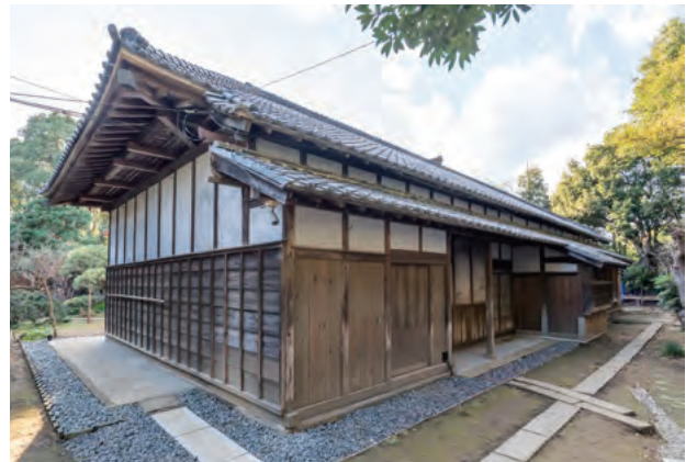
6. 主屋 竣工 ドマ東面及び北面
