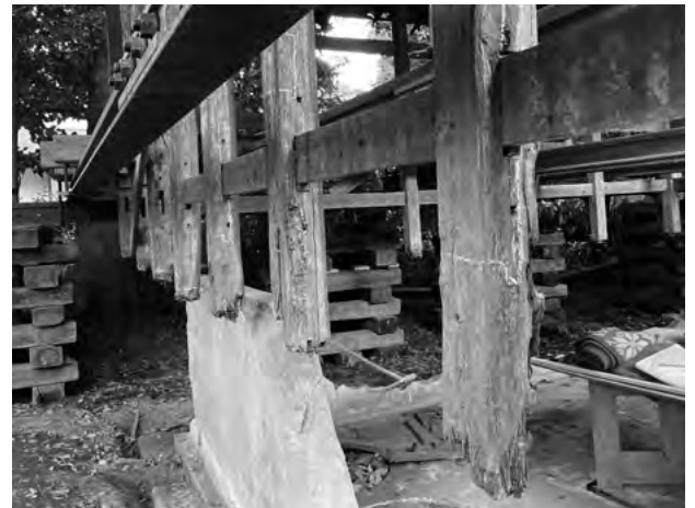
図 7-1-14 肥料小屋 西面柱（揚家時）
