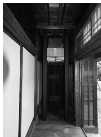
図 3-3-13 南縁鉄骨補強(竣工)
