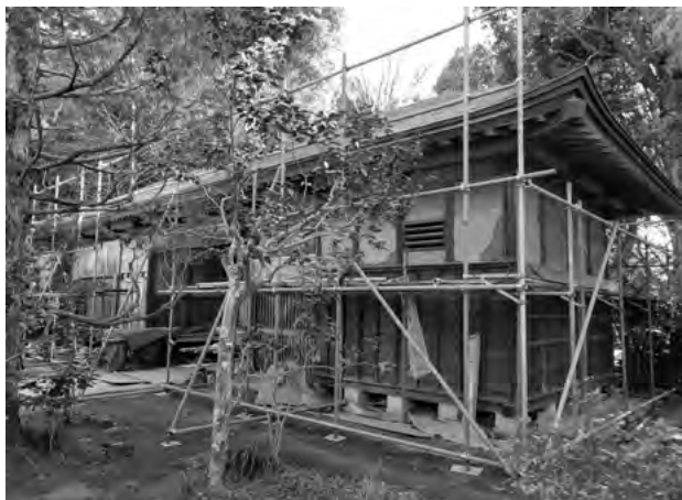
図 5-2-1 長屋門 仮設工事 足場
