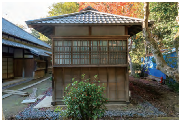
40. 風呂場 竣工 東面
