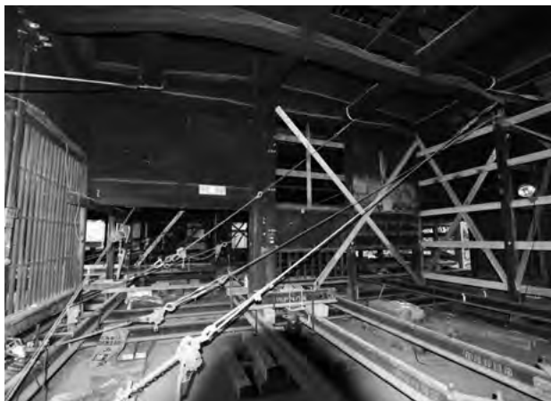
図 3-2-9 木工事 揚家 傾倒調整
