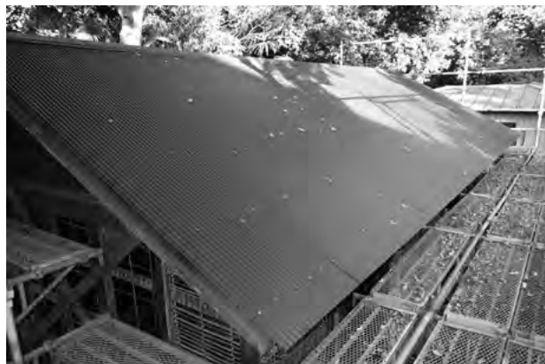
図 7-2-29 肥料小屋 屋根工事
