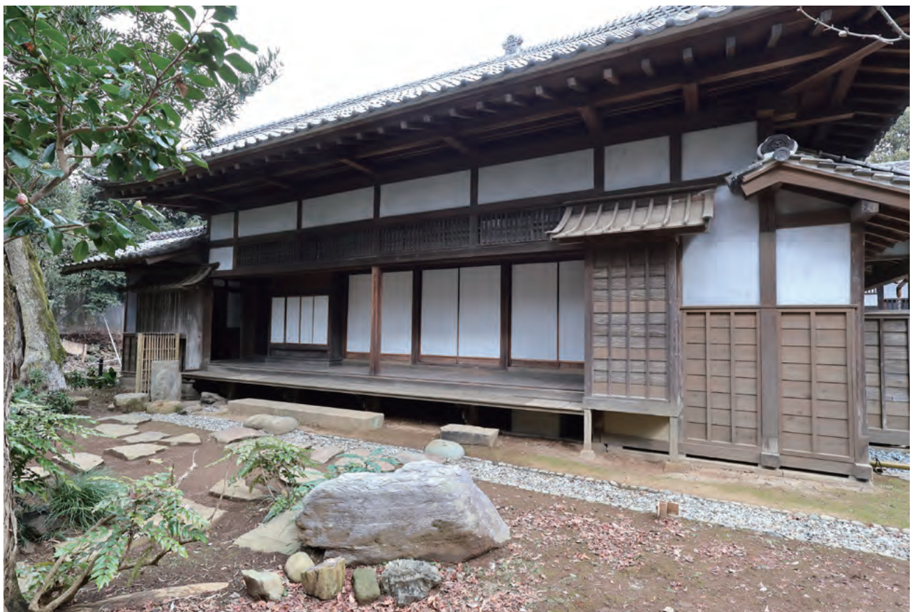
2. 主屋 竣工 南面
