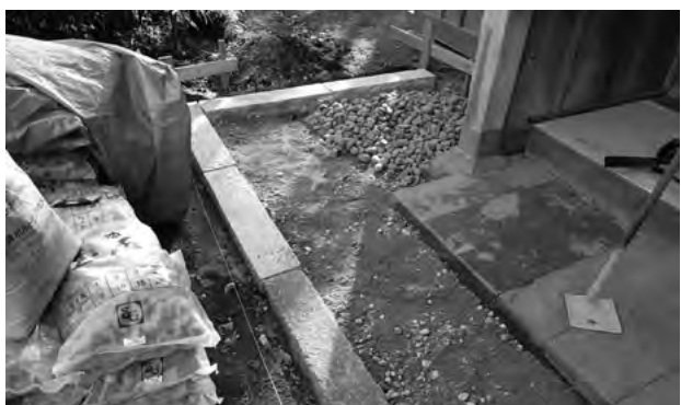
図 3-2-33 外構工事 式台玄関雨落ち
