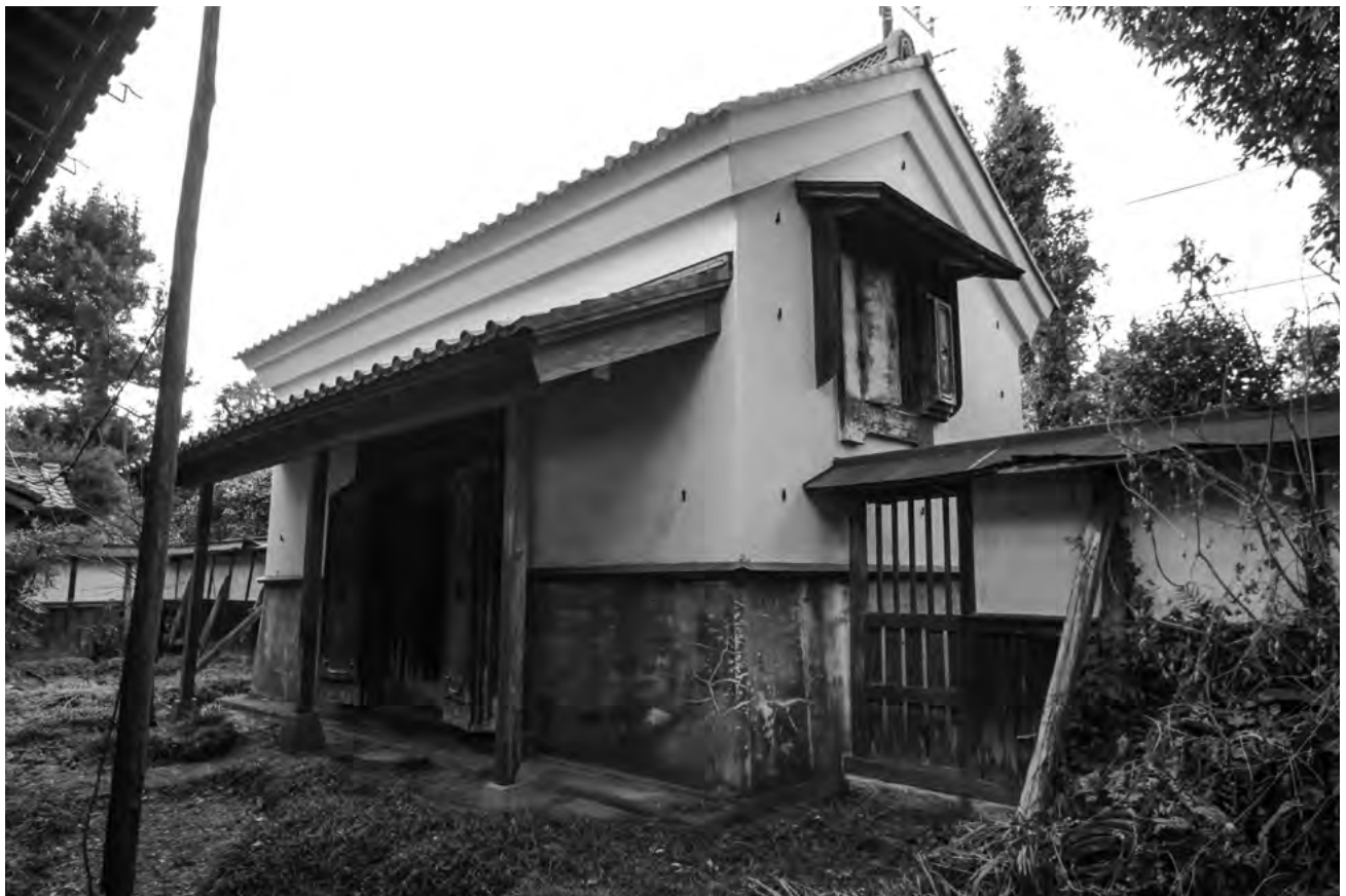
79. 文庫蔵 修理前 東面
