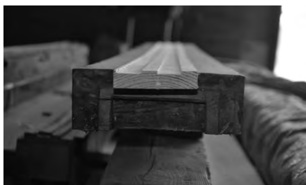
図 3-2-19 木工事 敷居 埋め樫の取替え
