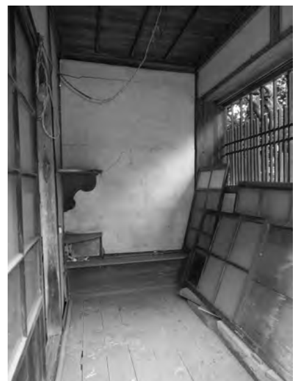
88. 風呂場 修理前 脱衣室
