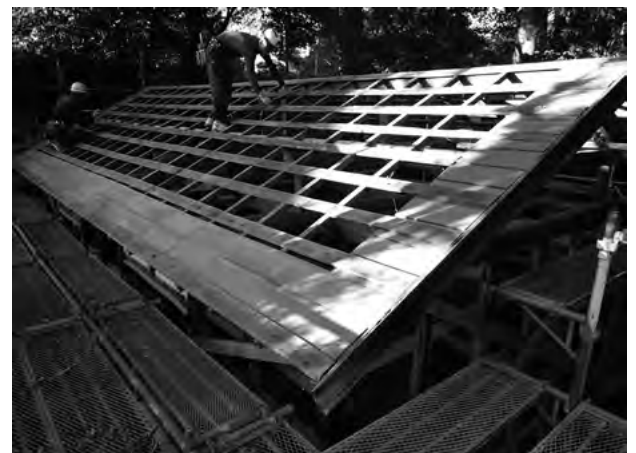
図 7-2-21 肥料小屋 解体工事 屋根解体
