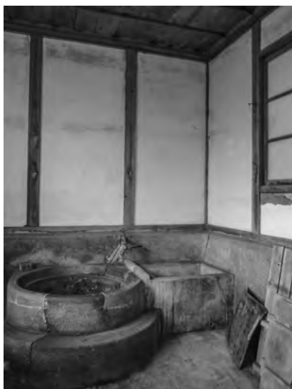
86. 風呂場 修理前 浴室
