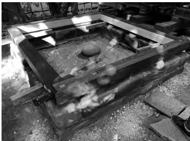
図7-2-3 稲荷社 木工事 土台敷
