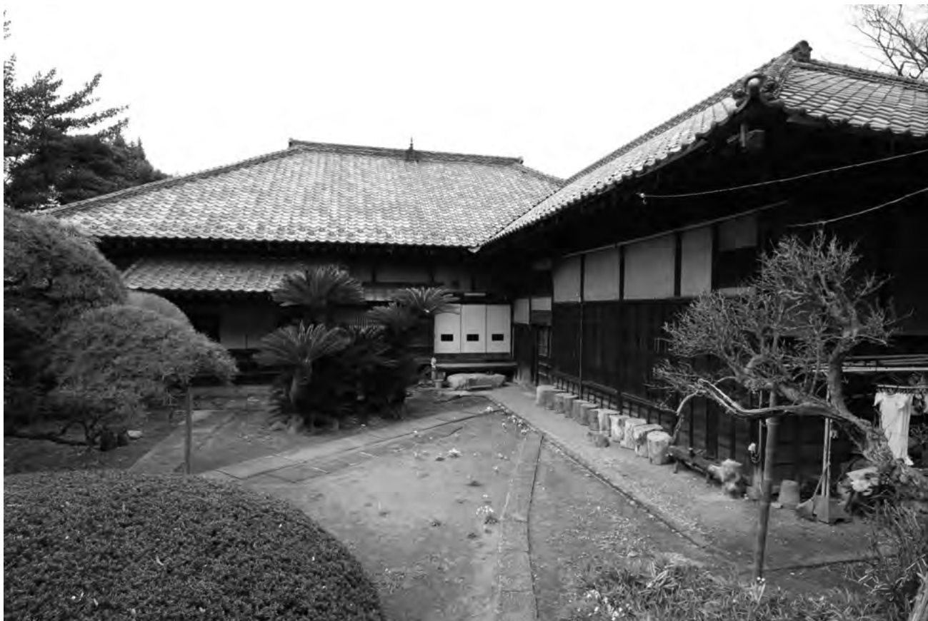
62. 主屋 修理前 東面
