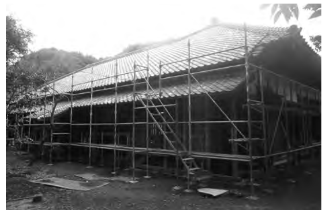
図 3-2-2 仮設工事 外部足場（北面）
