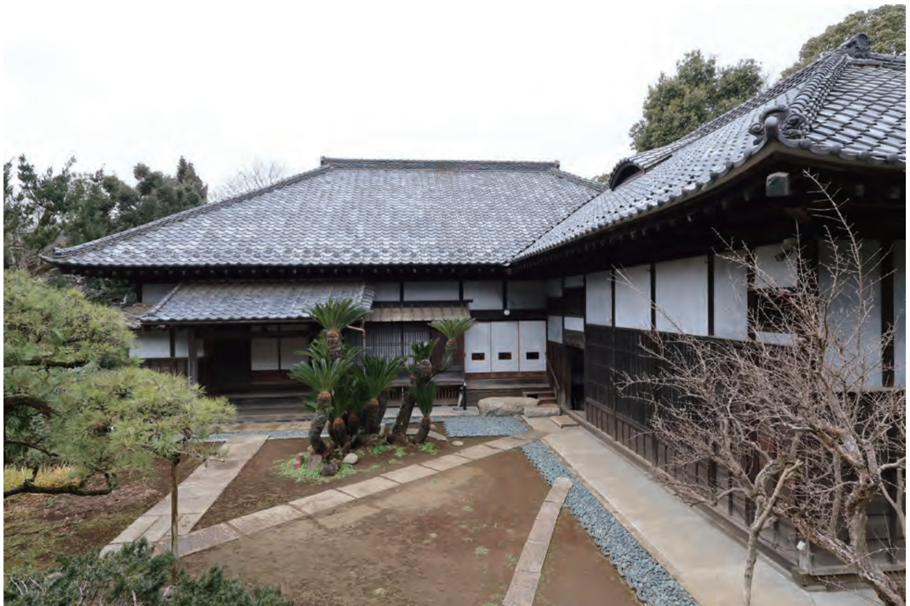
1. 主屋 竣工 南東入隅
