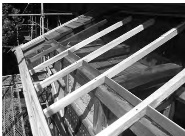
図 3-2-18 木工事 軒廻り 便所・暗室
