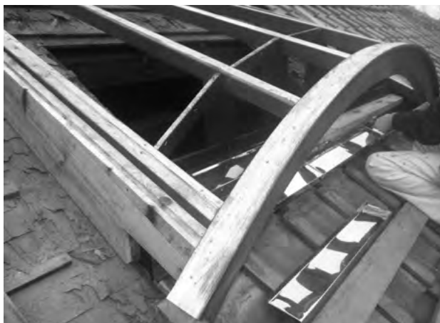
図 3-2-20 木工事 煙出し下地
