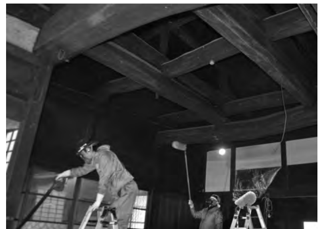
図 3-2-31 洗い工事 ドマ小屋組の洗い
