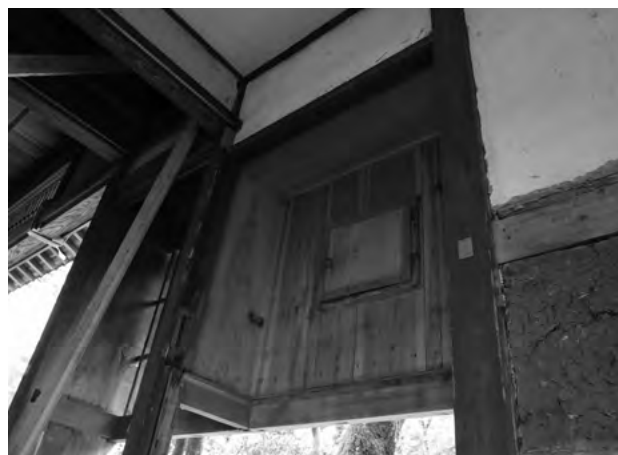
図 3-5-15 湯殿 窓の板張（解体時）
