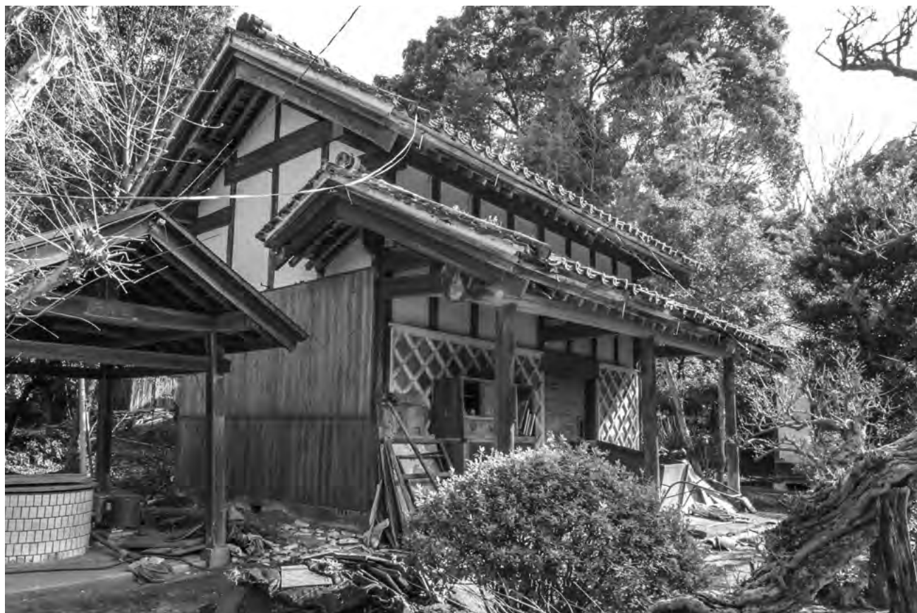
75. 前蔵 修理前 北西面
