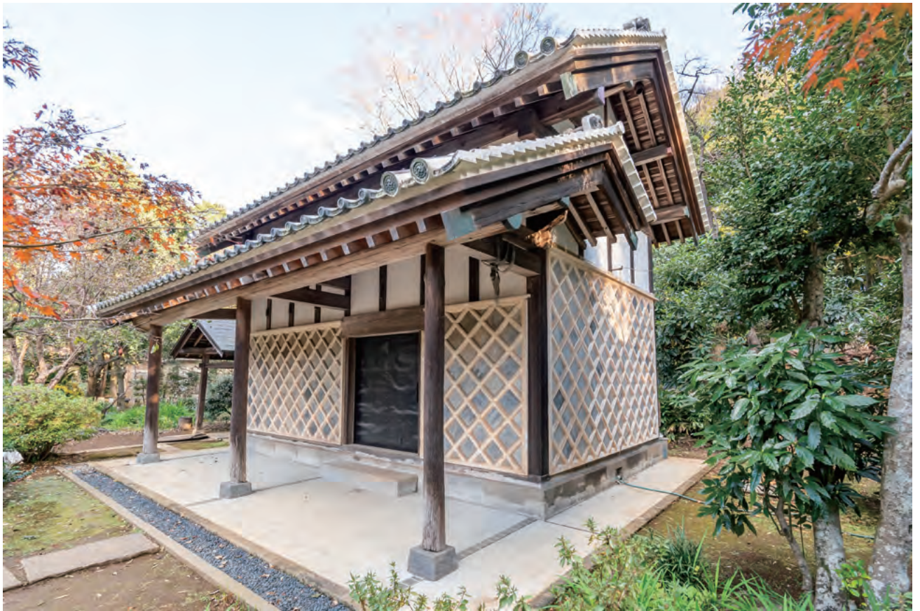
26. 前蔵 竣工 南西面
