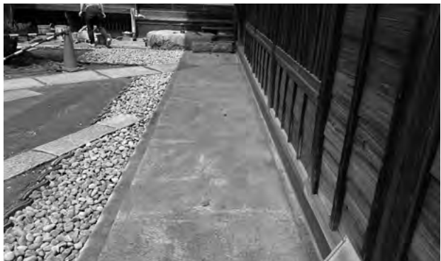
図 3-2-32 外構工事 犬走り
