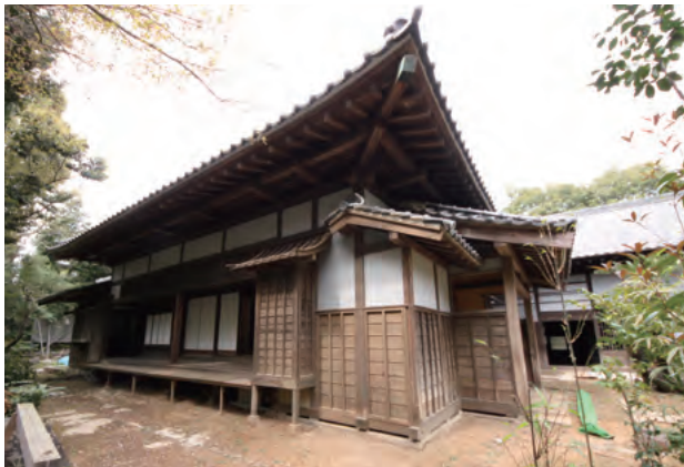
5. 主屋 竣工 南面
