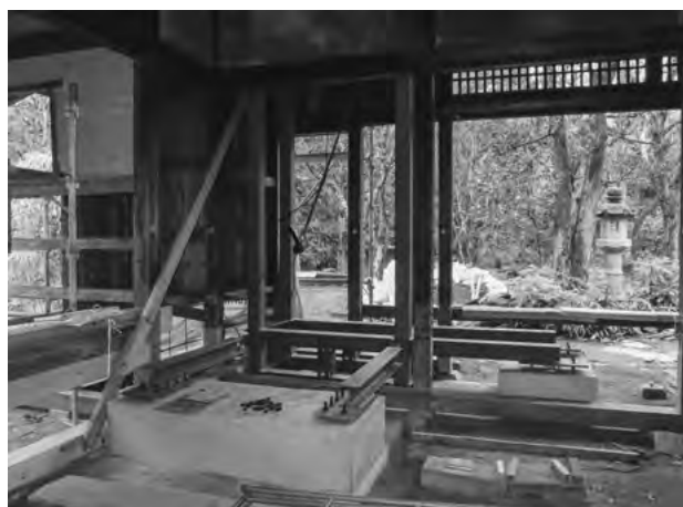
図 3-3-11 南東 鉄骨補強
