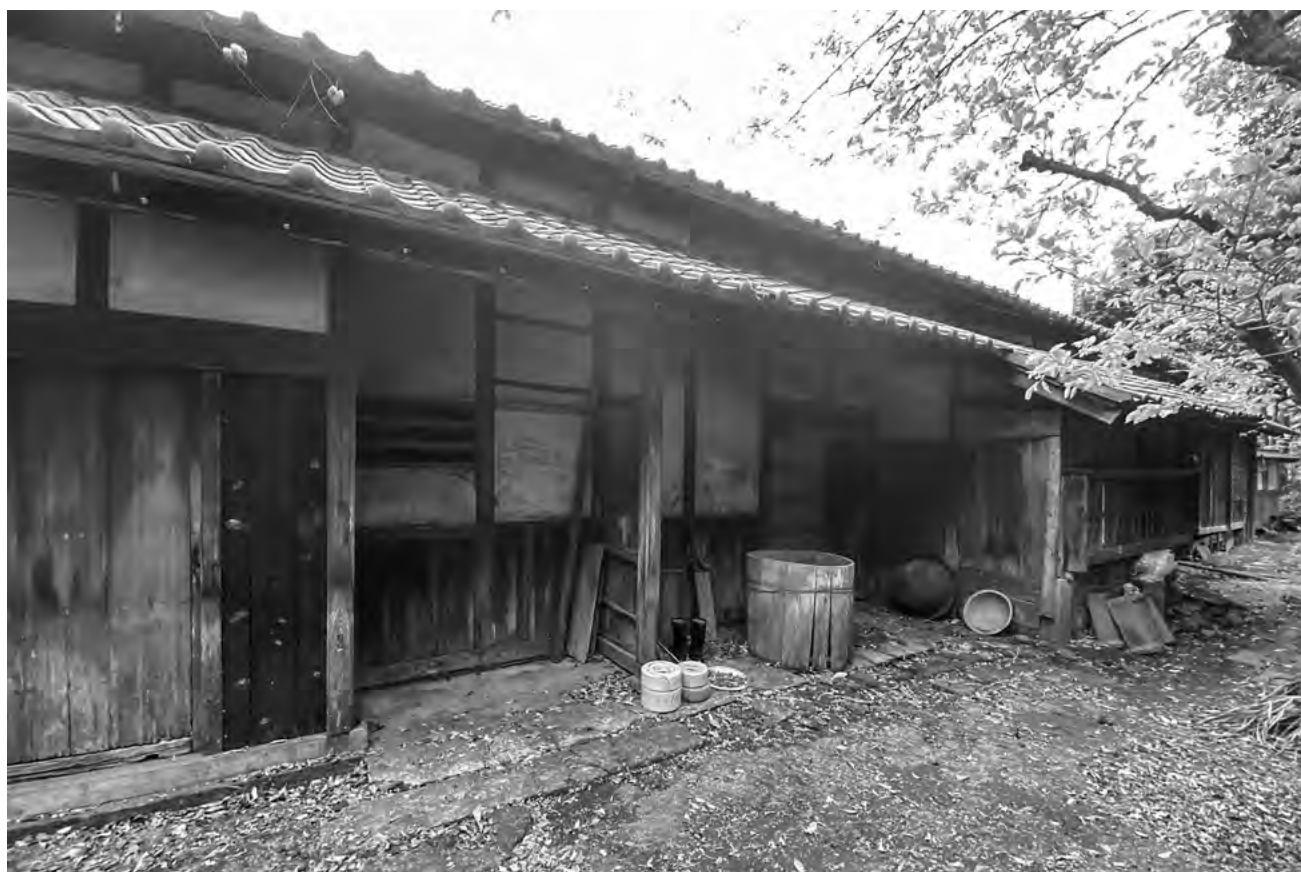
65. 主屋 修理前 北面
