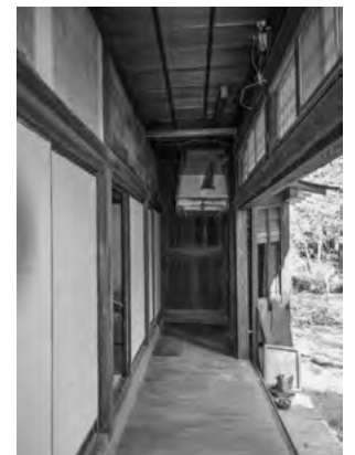
74. 主屋 修理前 南縁
