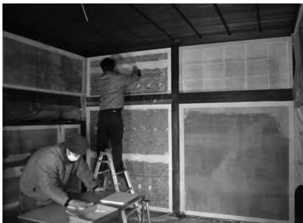
図 3-2-30 表具工事 オクノマ 壁紙下地
