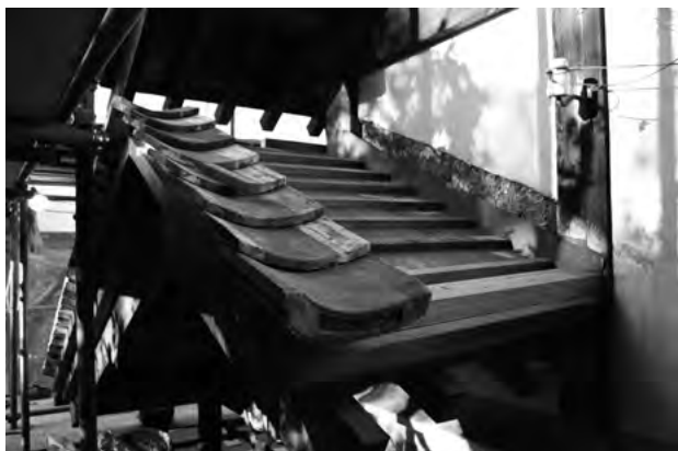
図 4-2-7 前蔵 屋根工事 土庇瓦葺
