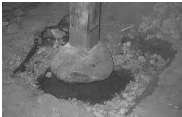
図 3-2-6 基礎・石工事 礎石の据直し
