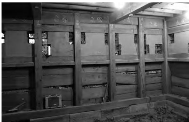
図 6-2-4 文庫蔵 揚家工事 土壁の部分解体
