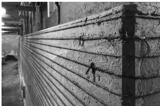
図 6-2-13 文庫蔵 左官工事 腰壁（型枠を外した後）
