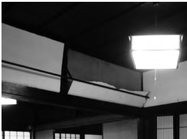
図 3-1-21 ホトケサマノヘヤ 壁剥落
