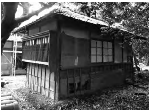
84. 風呂場 修理前 北面
