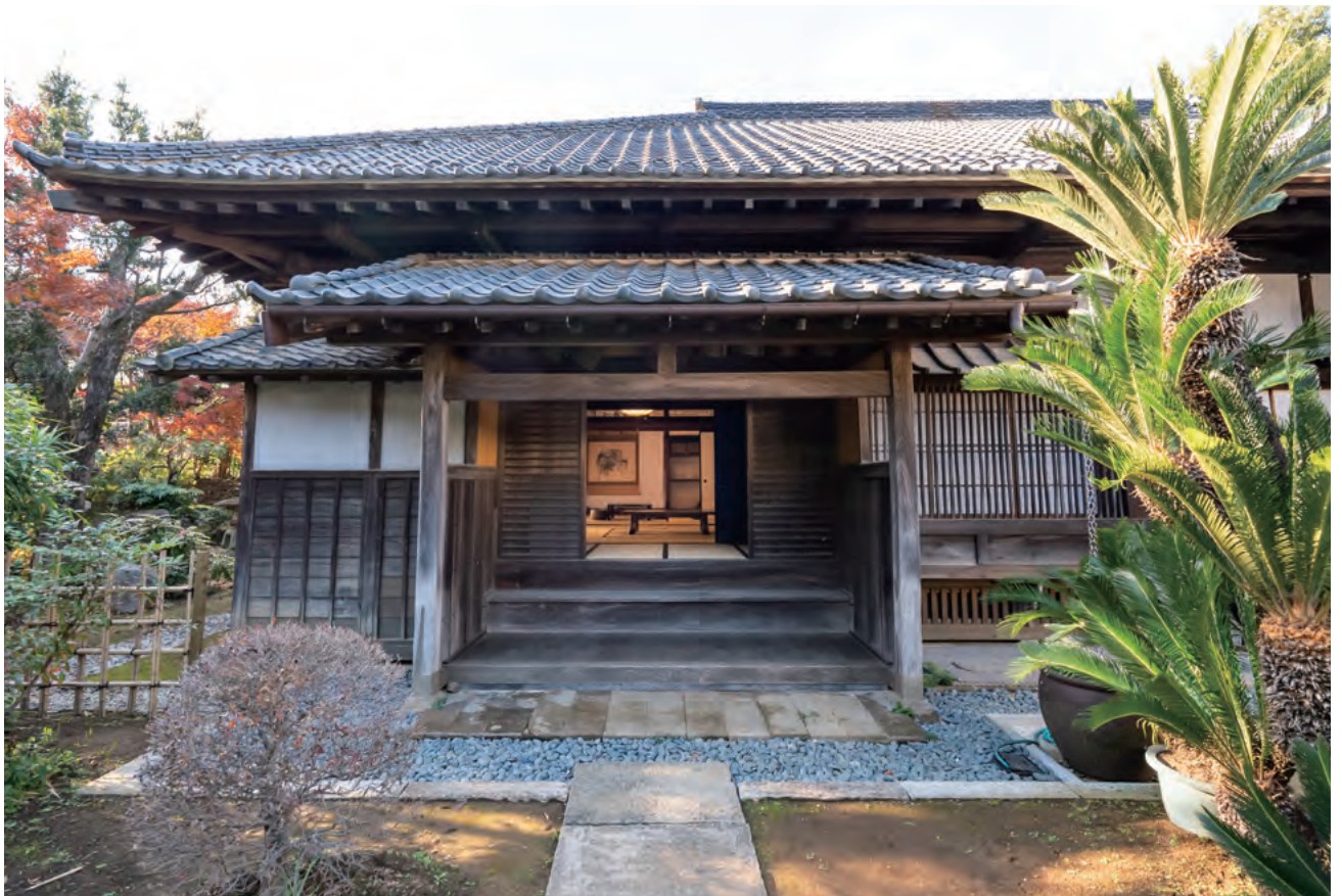
7. 主屋 竣工 式台玄関
