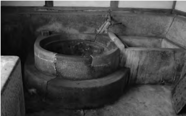
図 7-1-8 風呂場 風呂釜枠、腰壁
