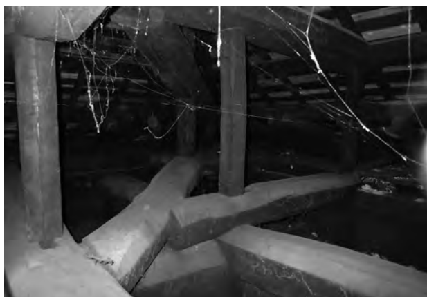
図 3-4-12 小屋組 隅木〔よ二十四〕（修理前）
