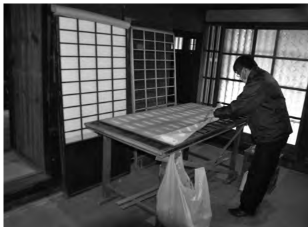
図3-2-29 建具工事 障子紙の貼り替え
