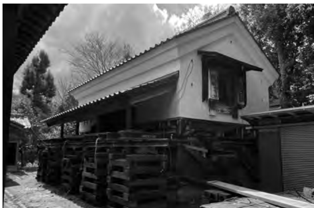
図 6-2-8 文庫蔵 揚家工事
