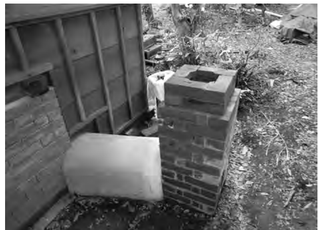
図 7-2-19 風呂場 左官工事 煙突煉瓦積
