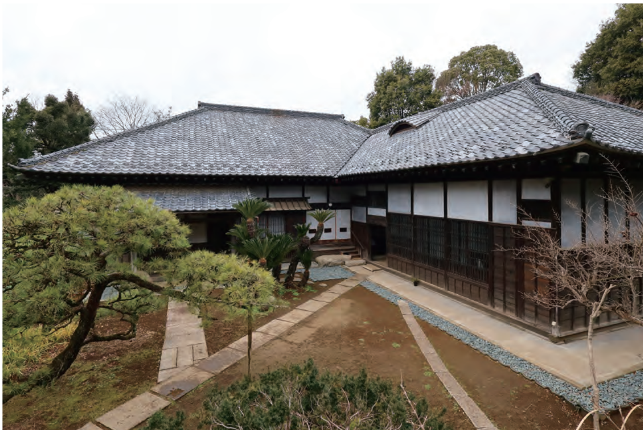
3. 主屋 竣工 正面
