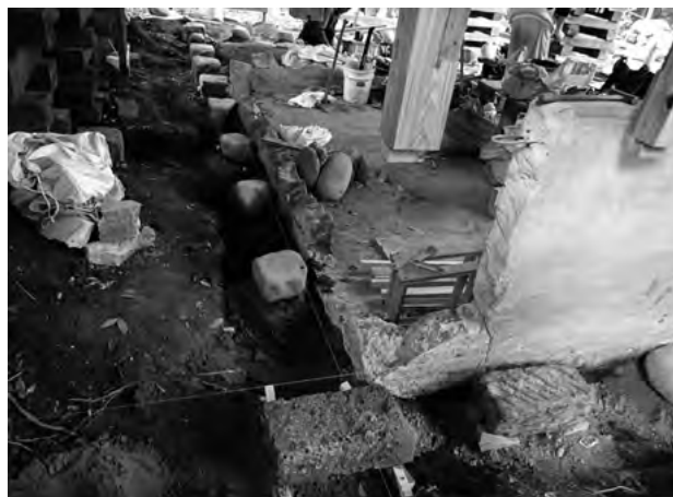
図 7-2-24 肥料小屋 基礎・石工事 礎石据え直し
