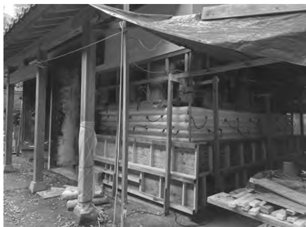
図 6-2-10 文庫蔵 左官工事 腰壁型枠
