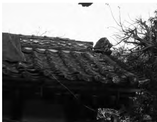
図 4-1-4 前蔵 平瓦及び鬼瓦のずれ
