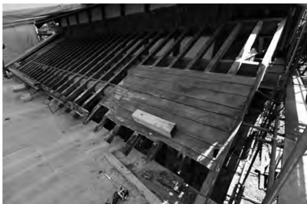
図 4-2-5 前蔵 木工事 土庇野地板, 野垂木の解体
