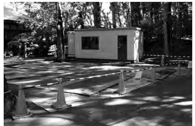
図 3-2-1 仮設工事 仮囲い（南面），作業員休憩所
