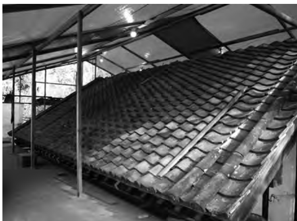
図 4-2-2 前蔵 屋根工事 土庇瓦葺
