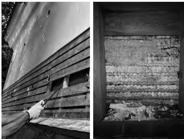
左：図 6-1-2 文庫蔵 外壁上張下地（解体時） 右：図 6-1-3 文庫蔵 腰壁の漆喰（解体時）
