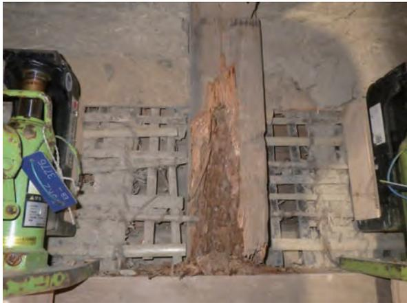
図 4-15 根継工事施工中
