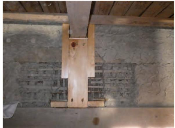
図 4-16 根継工事完了時
