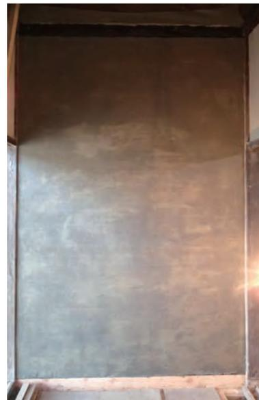
図 4-34 構造用合板下地土なめ塗り完了
