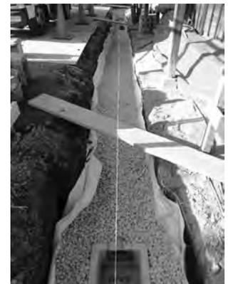
図 4-39 浸透トレンチ施工状況
