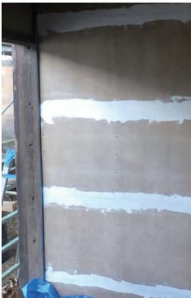
図 4-33 荒壁パネル下地目地処理
