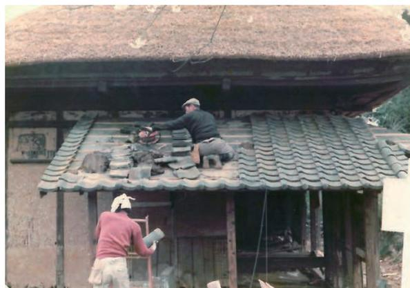
図 3-26 ゲンカン屋根瓦葺
