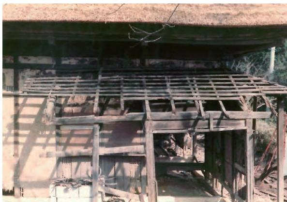
図 3-25 ゲンカン屋根下地解体
