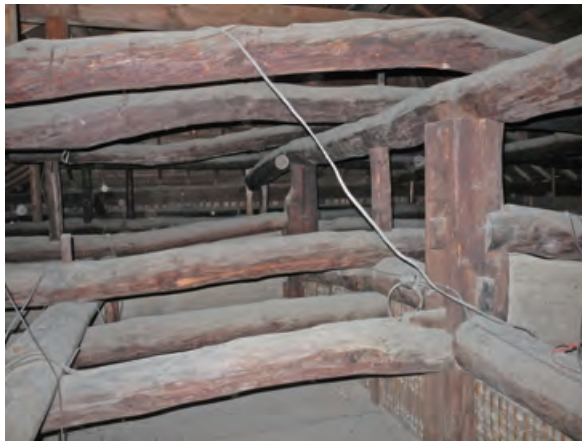
柱の上端を切り縮め、曲がった木材からなる小屋組の位置を ずらして再利用している。
