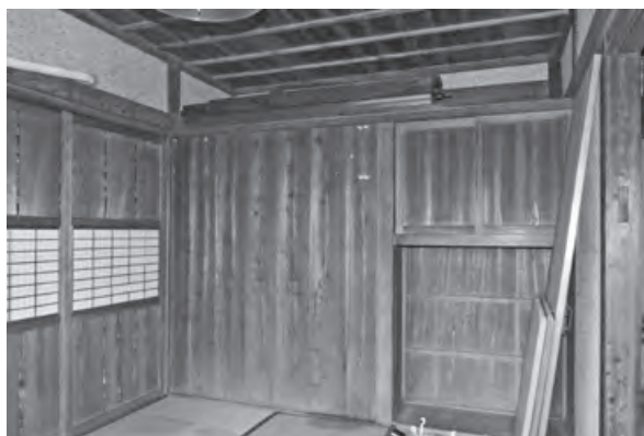
納戸 座敷の仏壇と押入の裏側が見える。南壁(画面右)から奥の間に入りできるように改造された。
