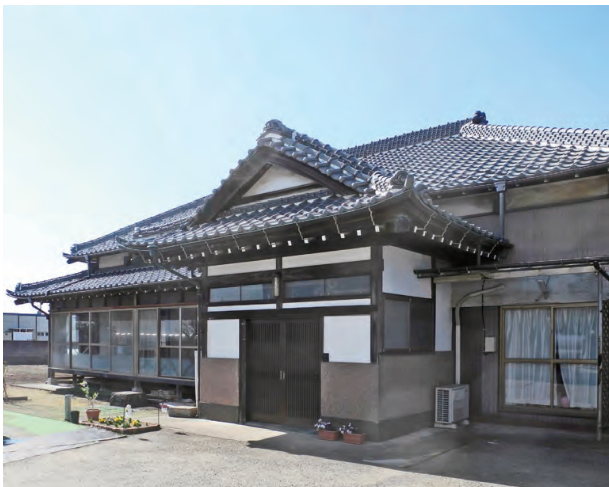
正面 玄関 北東から見る。
