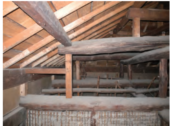
新設された桁を繋ぐ部材や野垂木・野地板が新しくされた。 土壁の取り付く梁を含む下方の梁組は再利用された。
