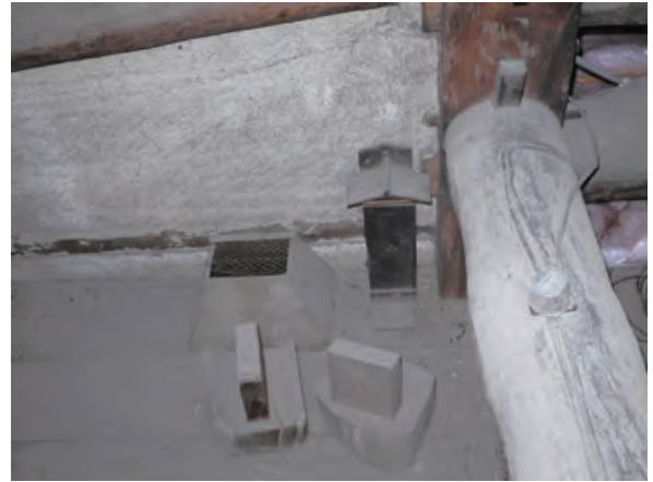
大黒柱の天井裏には、昭和47年の修理で切断した大黒柱と 第2大黒柱の上端と札箱が置かれていた。奥に天井換気口。
