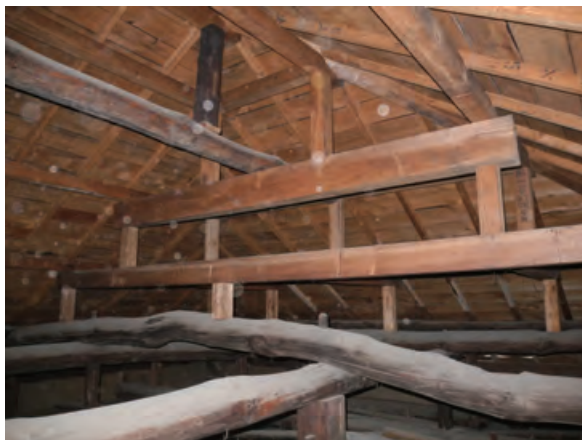
新材で瓦葺のための小屋組を設けた。棟木を支える部材には 「棟束」と記す。煤けた棟束は当初材を再利用したもの。
