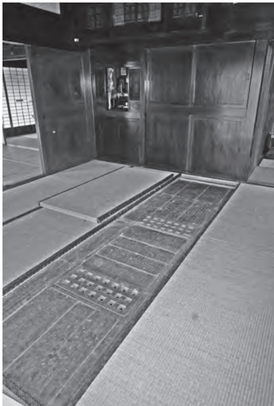
座敷 畳の下に発見された囲炉裏は、養蚕用に開発された効率の良い火炉の形式
