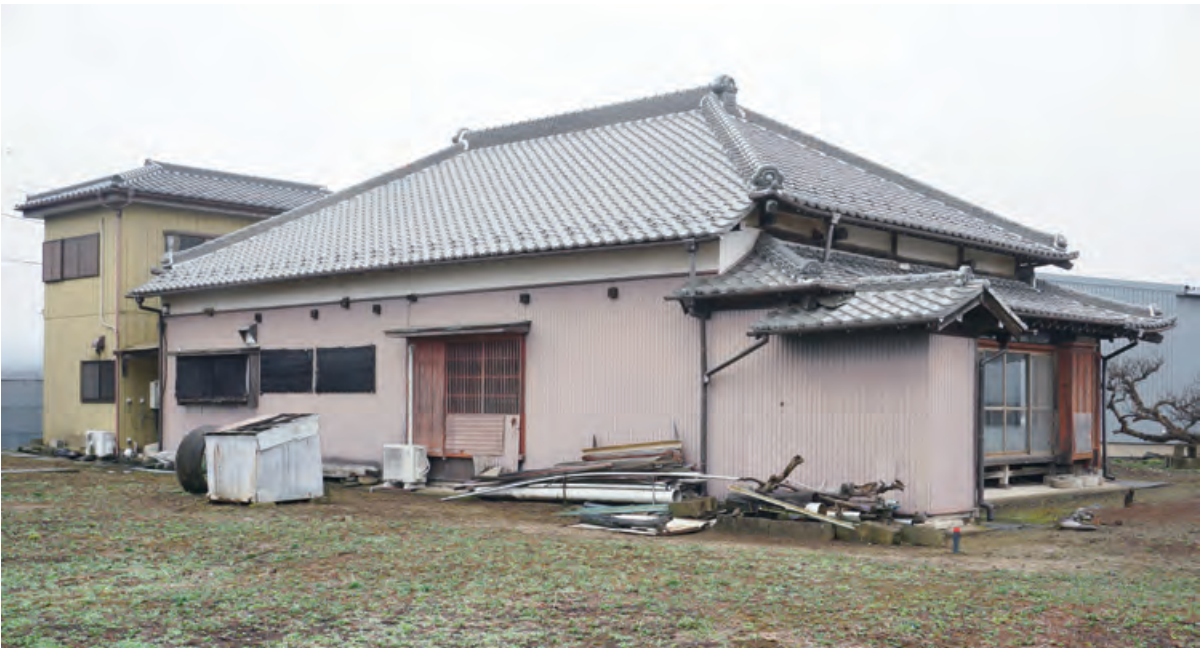
背面 南西から見る。壁上方には小屋組の梁小口が出ている。
