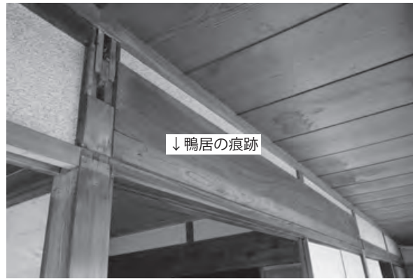
① 中の間一東縁境の差鴨居外側には、式台玄関の鴨居痕跡が見られる。画面左側に②③に見る戸袋が付くので、③の柱に袖壁の痕跡はない。
