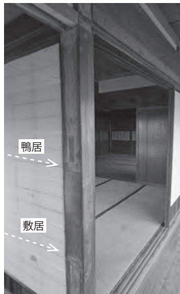
③ 式台玄関戸袋内側の壁の痕跡(南面)。②に対となる痕跡
