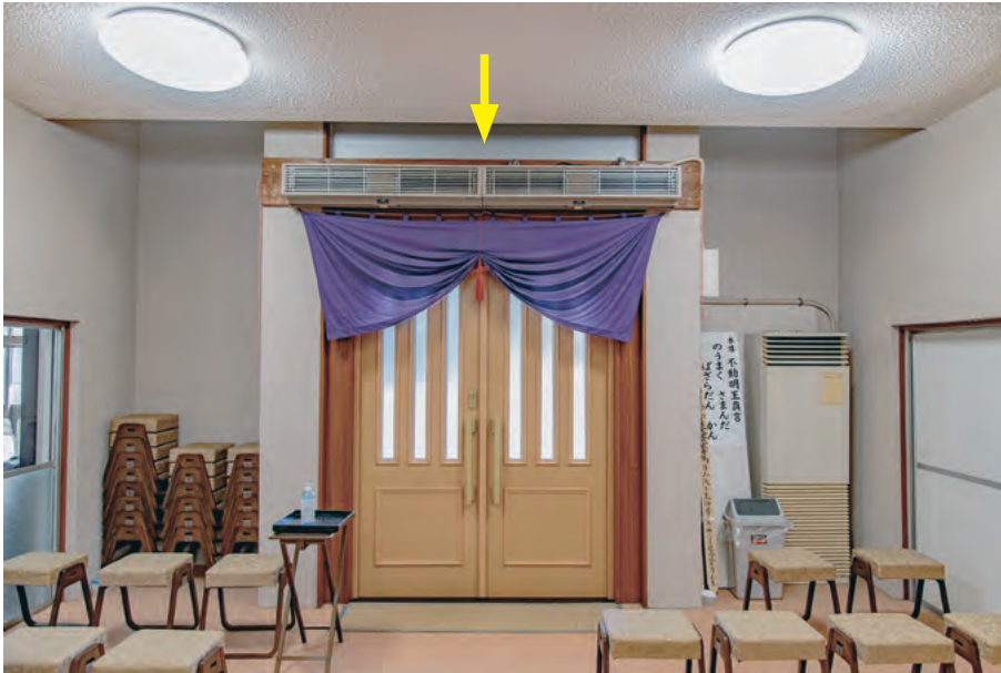
玄関扉上には彩光の得られる欄間窓（閉鎖されている）
