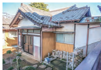
宗寿寺客殿 渡り廊下で本堂に接続
