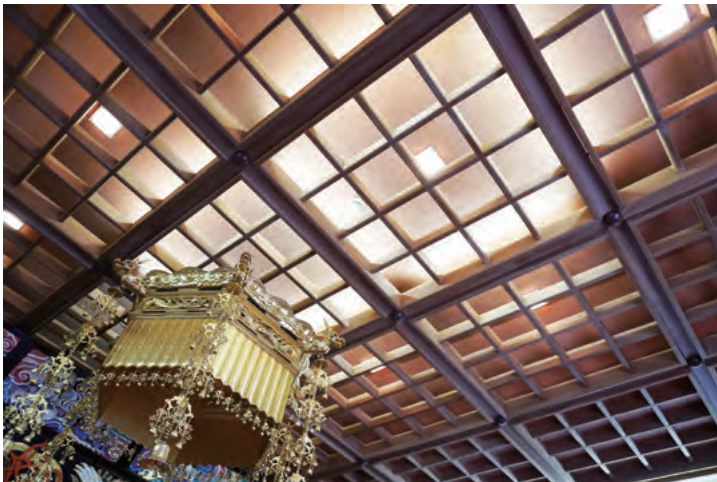
外陣天井見上げ 中央の通りには電気照明が埋め込まれている。
