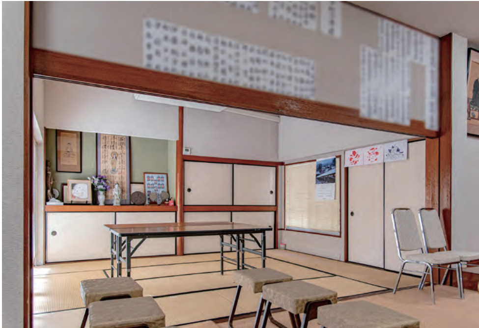
西室を外陣から見る。外陣境には引き違い戸を建て込むようになっている。
