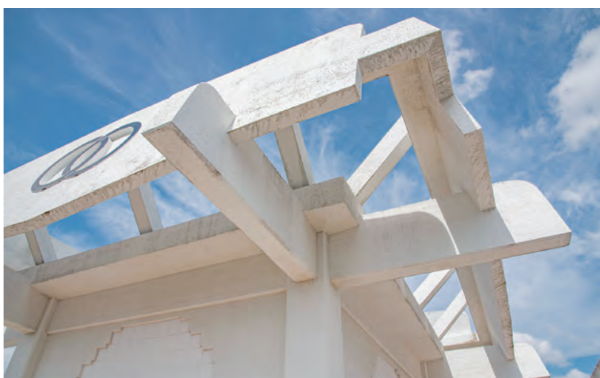
反射板は梁と控えで支えられる。
