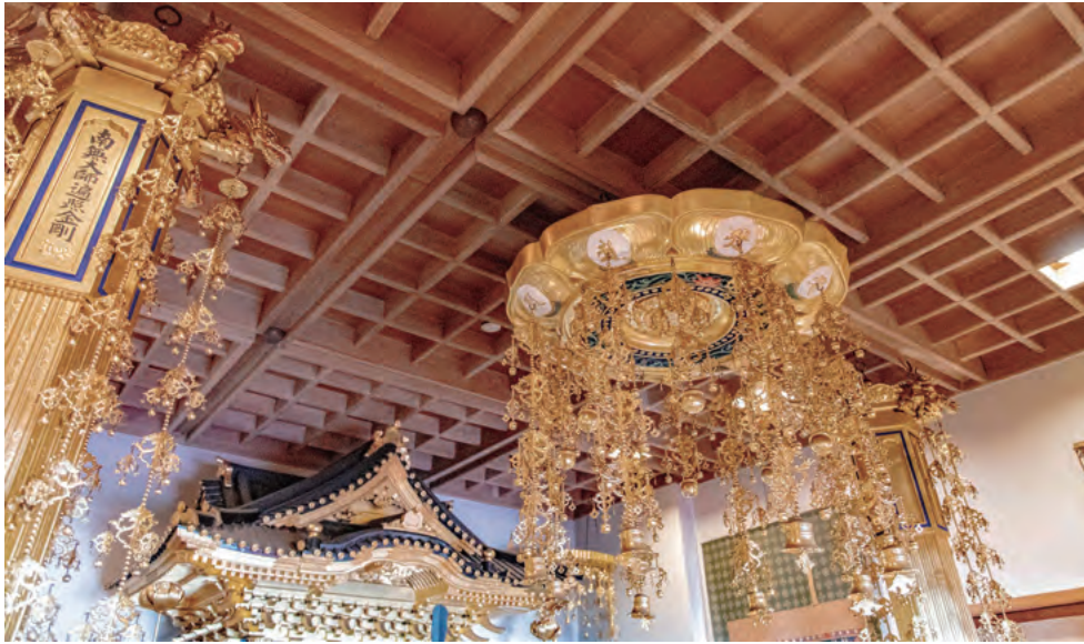
内陣天井を見上げる。
