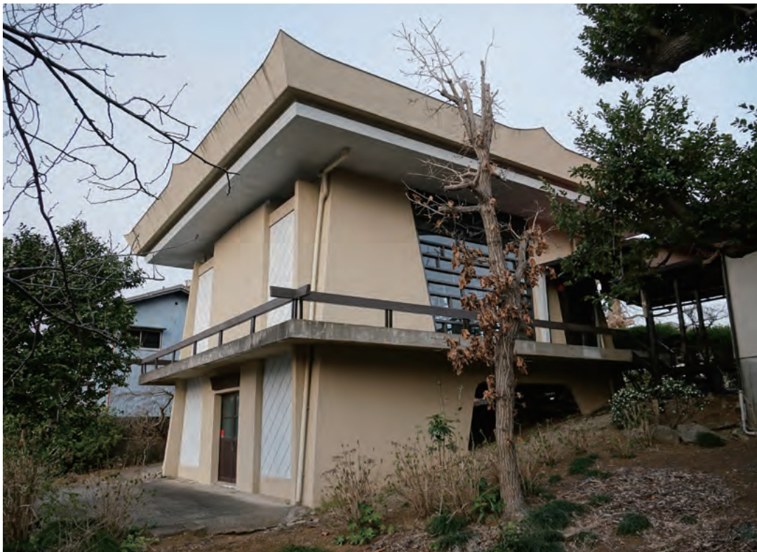
背側面 間口が1階で9mの末広がりの壁は、下階で間口9.75mになる。納骨堂の奥行は9尺(2.7m)
