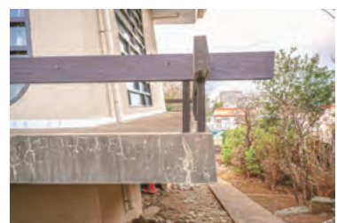
鉄製縁高欄 隅部
