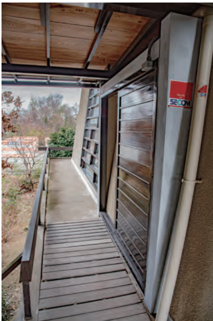
庫裡側の縁 本堂側面に出入口がある。(右図)
