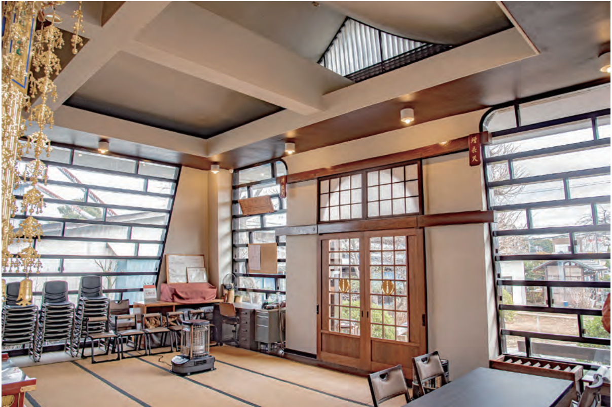
外陣見返し 正面と両側面の大きな開口部に加え、正面の妻からも彩光が得られる。 本堂への出入口は、内側に引き分けのガラス戸、外側に木製の開き戸を重ねる。
