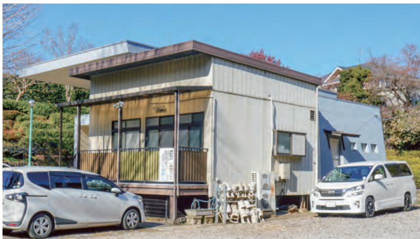
増築部全景 南東から見る。
