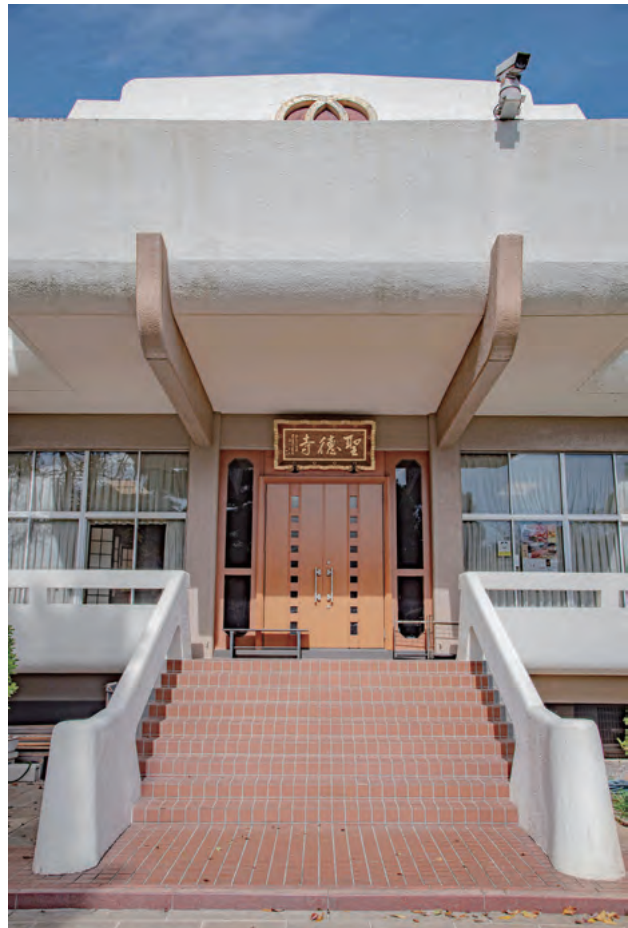
正面玄関廻り
