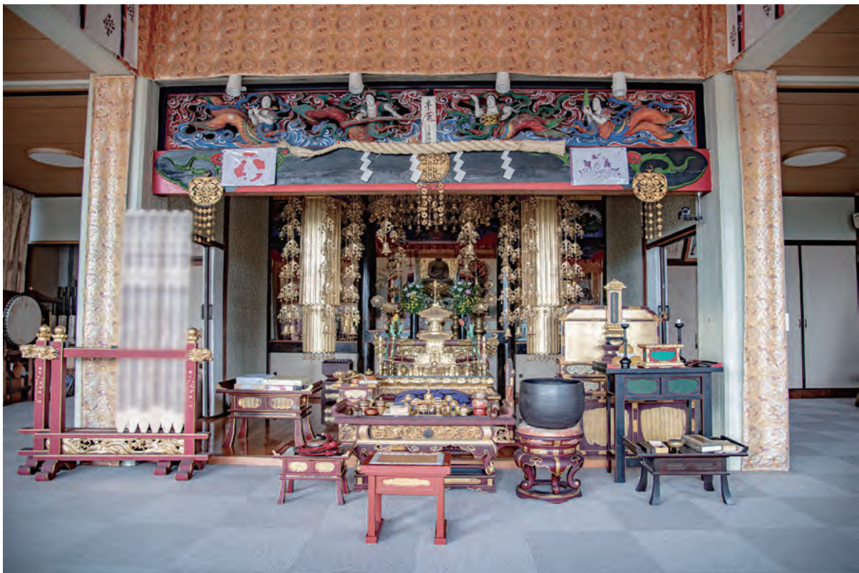
内陣正面 内外陣境には、前身本堂の欄間が再利用されている。 これらの欄間が納まる寸法である2間半=4.5メートルに、内陣の間口は設計された。
