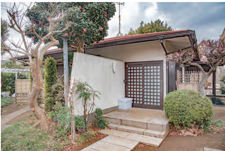
庫裡 本堂南側に渡り廊下で接続する。本堂と同時期に木造で建てられた。
