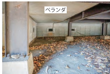
増築部の床下にはベランダが残る。
