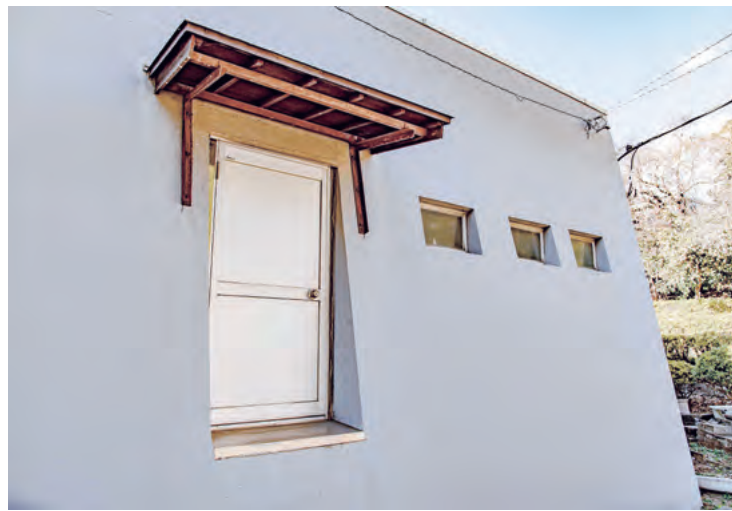
前室の外部 庫裡への渡り廊下が接続していた扉と便所窓 上の写真とあわせて見ると、斜めの壁がどのように室内に見えるかわかる。
