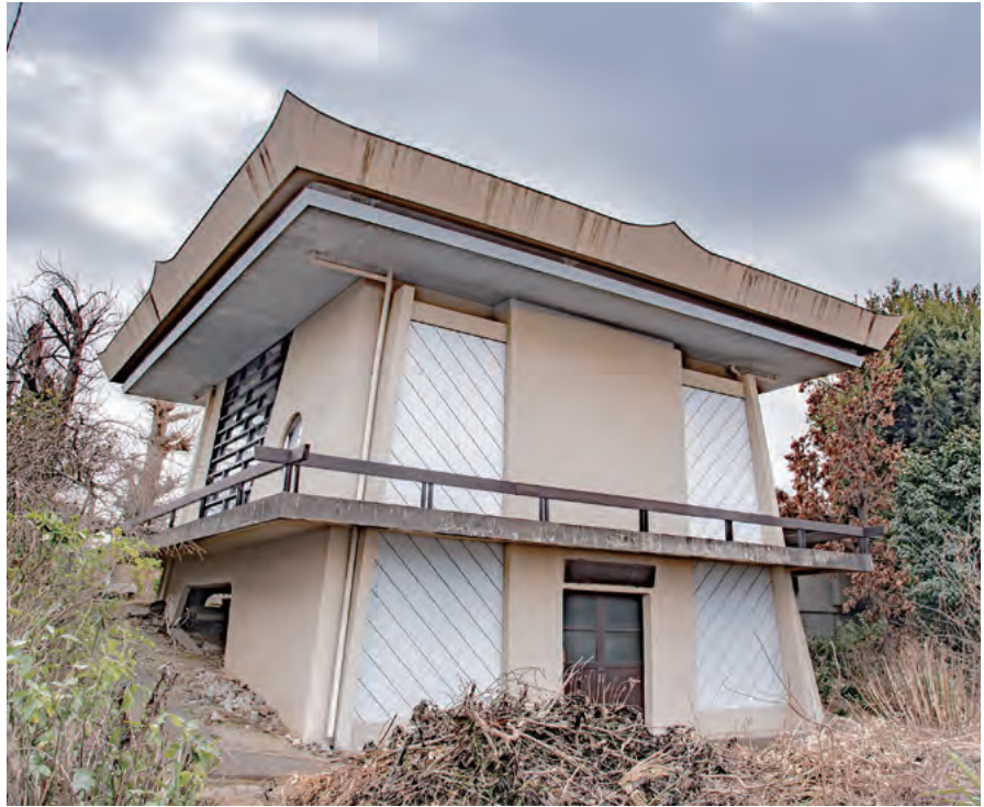
本堂背面 斜面に立ち、下層は背面側にのみある。背面中央の扉から安霊室に入る。
