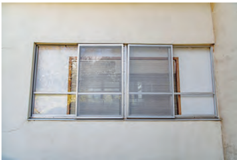
東室北側の窓を外から見る。サッシの内側に障子戸を入れる。(現在障子戸はない)
