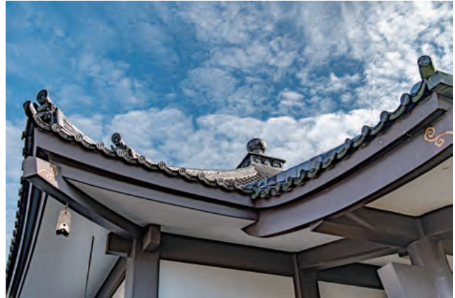
本堂への向拝取り付き部分見上げ 化粧隅木に風鐸
