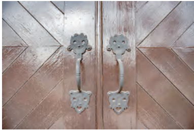
玄関扉引き手
