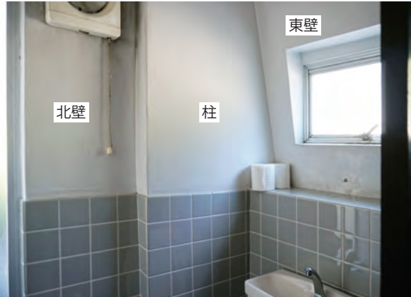
便所 北東隅に柱がある。
