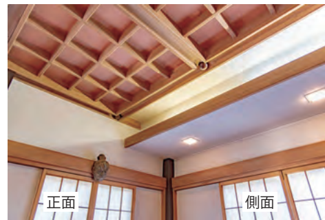
外陣天井造作
