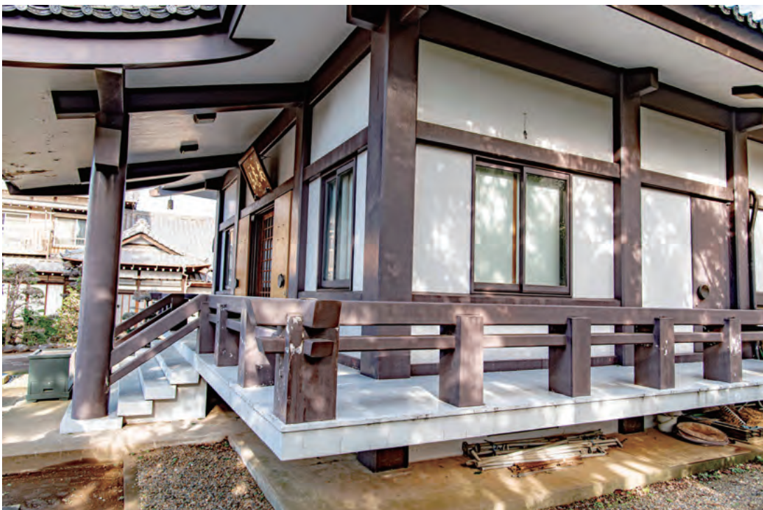
本堂 正側面 南から見る。
