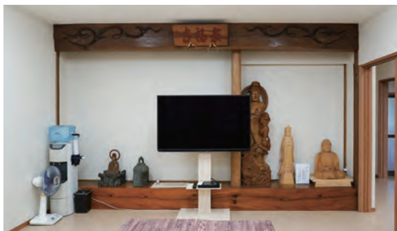
客殿広間の床には前身本堂の虹梁が用いられている。
