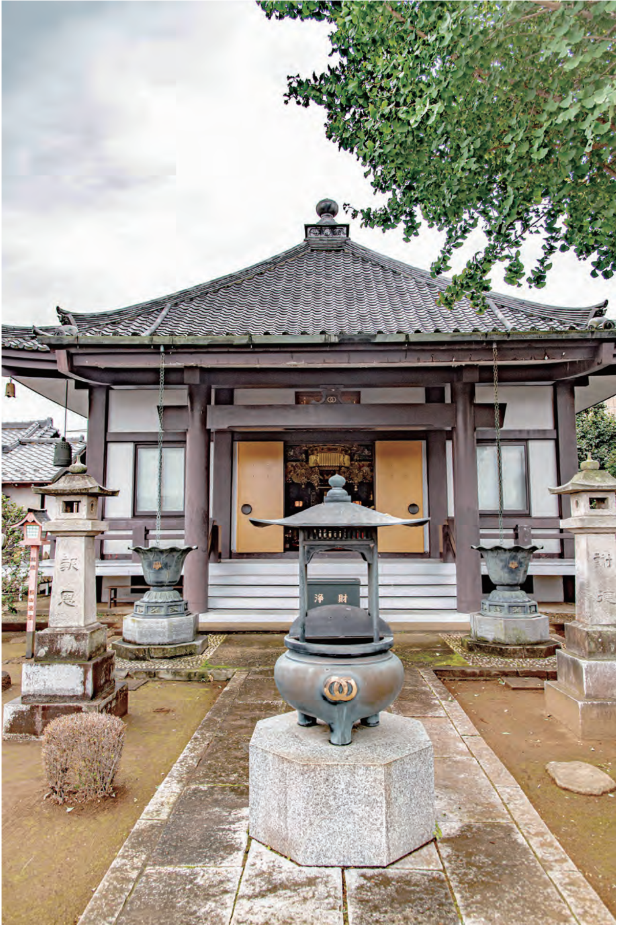
本堂正面全景
