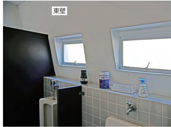
便所 東壁は壁の勾配がそのまま室内にあらわれる。
