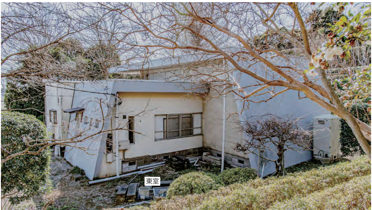
東室を背面から見る。
