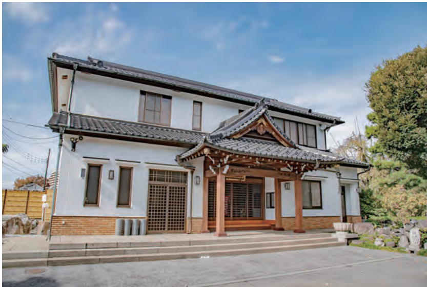
集会に利用される阿弥陀院（1984） 軽量気泡コンクリートパネルを用いて建て、7年に1度、コーキングとペンキ塗を行う維持管理をしている。
