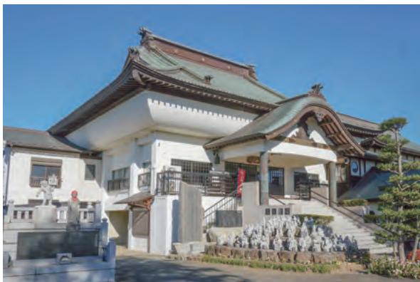
慈本寺 近代式→伝統式 後年和風の屋根に改修
