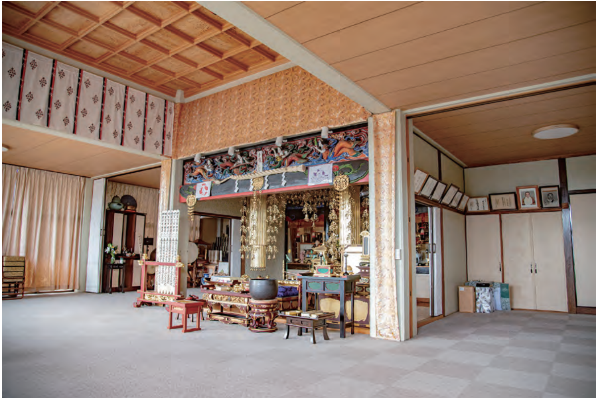
外陣から内陣を見る 内陣前の外陣の格天井は、当初吹き抜けて屋上から自然光が四方から注ぎ込む形式であった。
