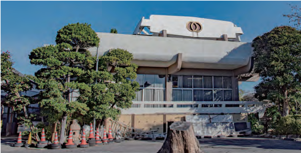
本堂西側面 本堂に向かって左手には、檜の木2本の切り株がある。
