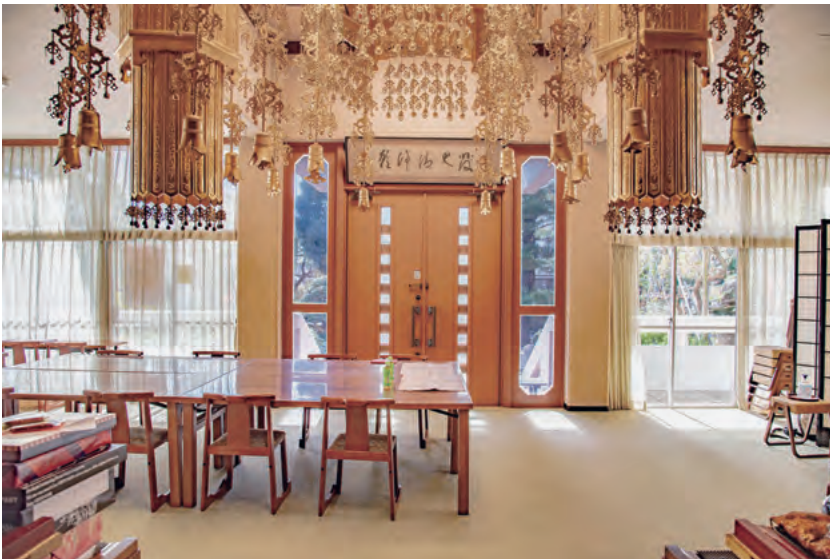
玄関 扉は取り替えられている。以前は、寿量院と同じ形式であった。周囲ガラス戸のサッシは当初のまま。
