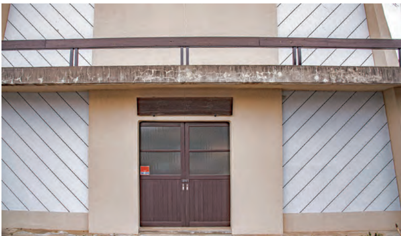
納骨堂出入口 「安霊室」と掲げられている。
