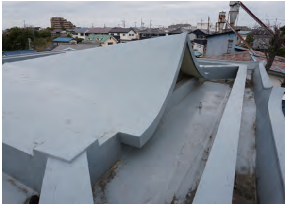
屋上から屋根を見る。
