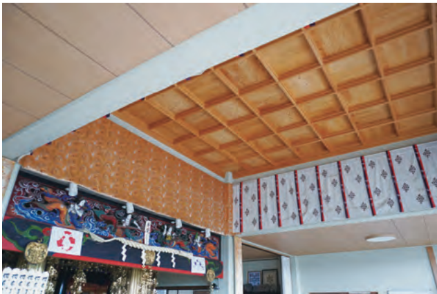
現在外陣には格天井が張られている。当初の外陣天井は吹き抜けであった。
