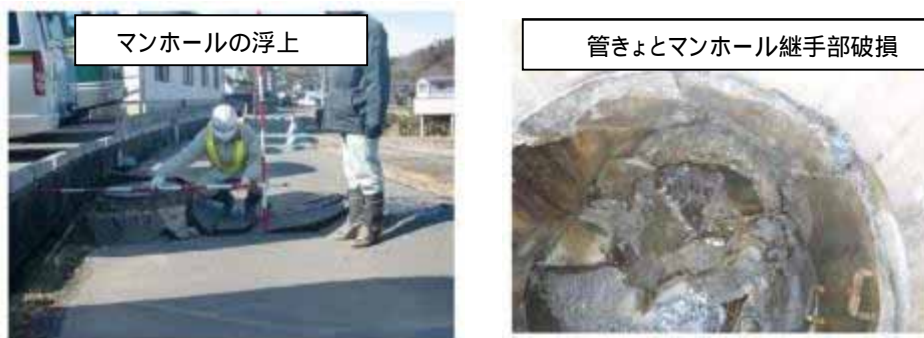
図 2-3-4 地震による管路施設の被害例
