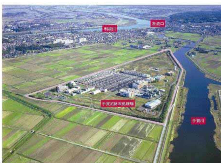
手賀沼終末処理場全景写真
