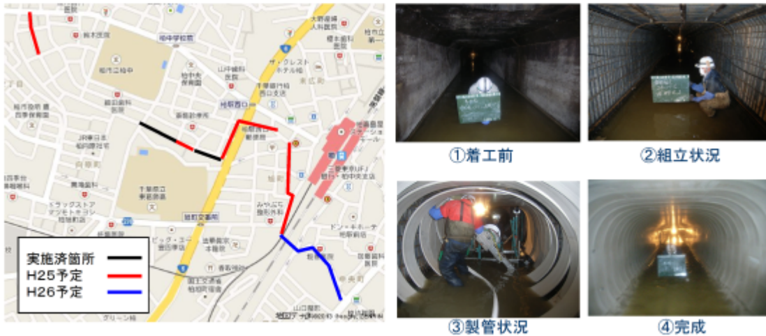
図 2-6-4 着工中の長寿命化計画
