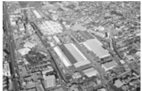
柏市公設総合地方卸売市場
