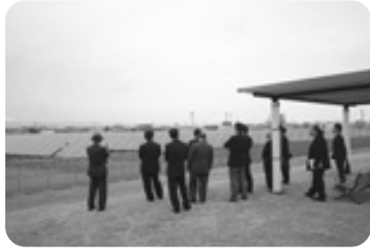
富山太陽光発電所
