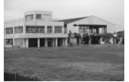
被災した小学校（仙台市）
