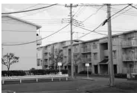
市の集合住宅(市営住宅)
