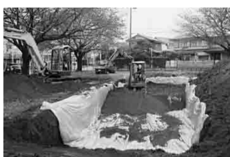
千代田公園の除染作業
