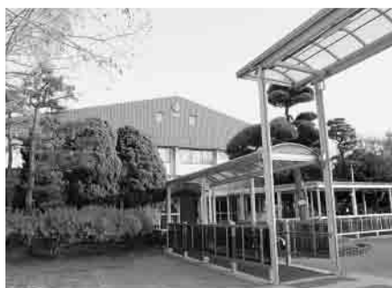
柏中学校の体育館
