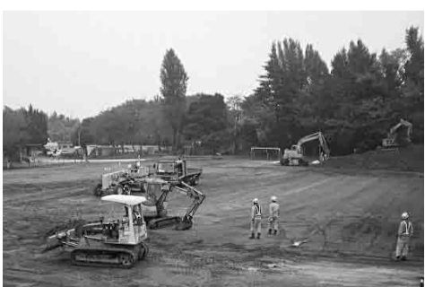
田中北小学校で行われた除染作業
