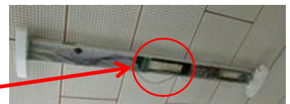
蛍光灯の安定器
