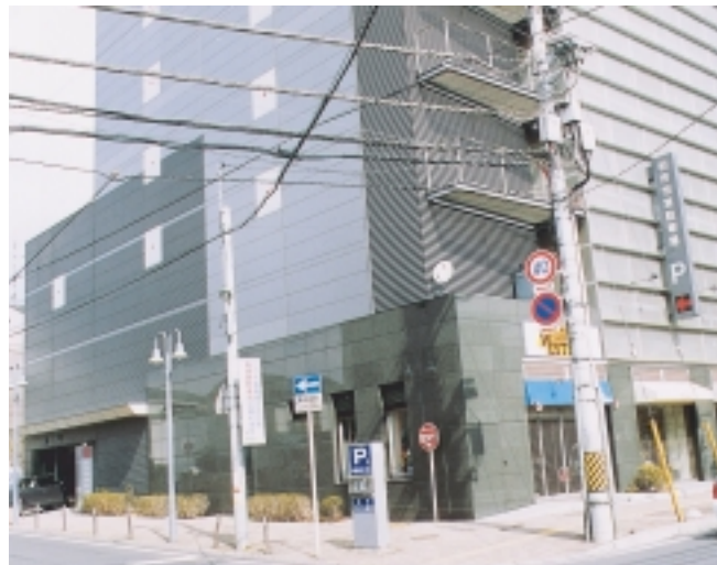
低公害車利用の市民のかたに市営駐車場の料金を助成
