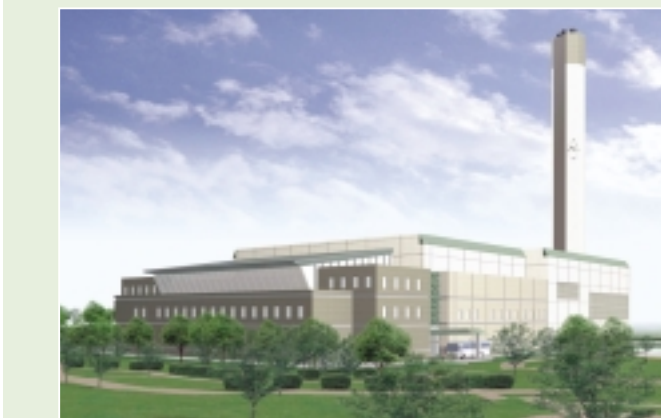
第二清掃工場の全景(イメージ)
