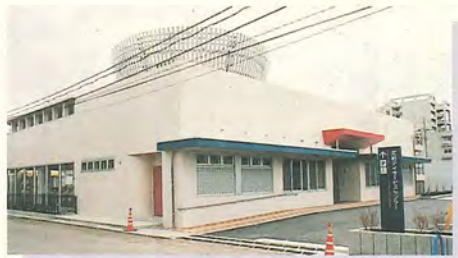
根戸の市営住宅に隣接して開設された、北柏デイサービスセンター。
