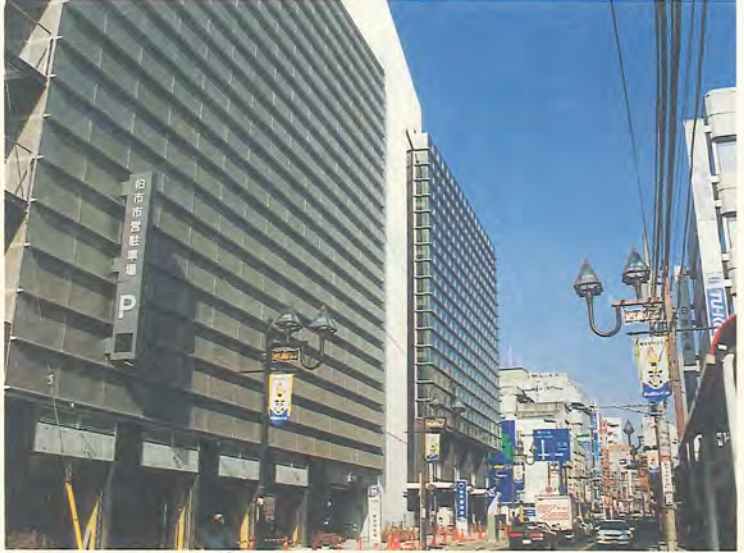
完成間近の柏市市営駐車場
