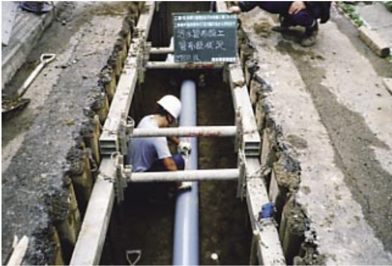
ますます広がる下水道（污水管の敷設工事）
