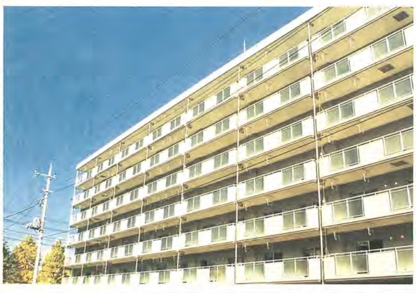
まもなく完成する市営北柏B棟
