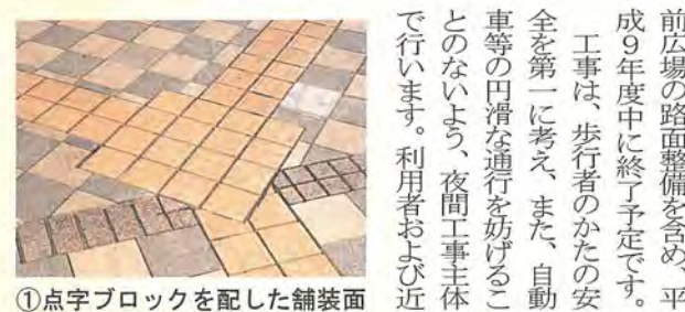
①点字ブロックを配した舗装面
