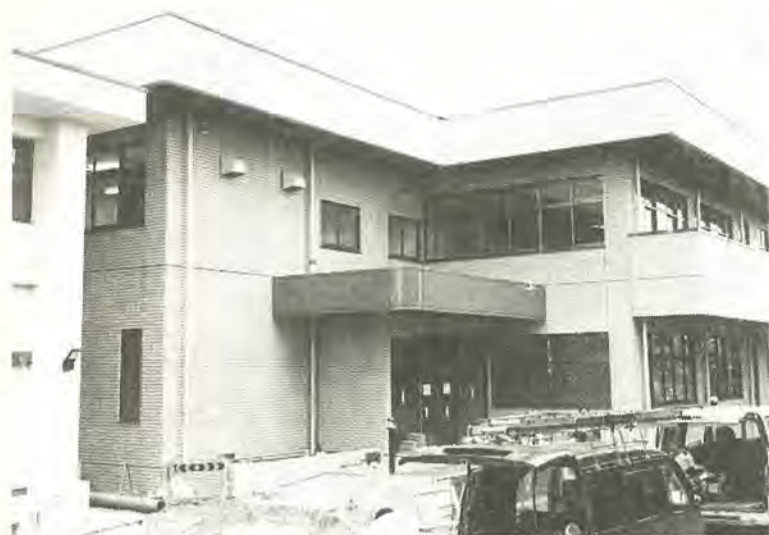
完成間近の旭町近隣センター
