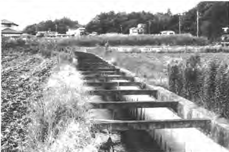
雨水幹線工事が浸水防止に役立ちます。写真は既存の水路
