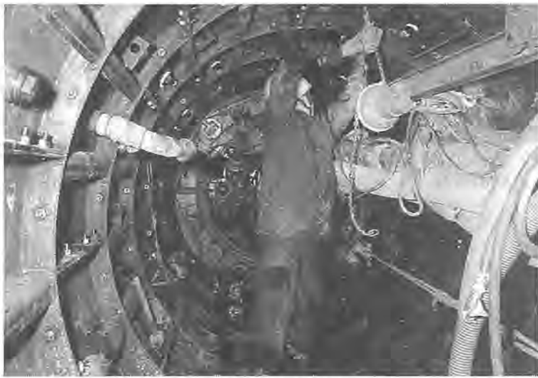
積極的に進められる公共下水道工事
