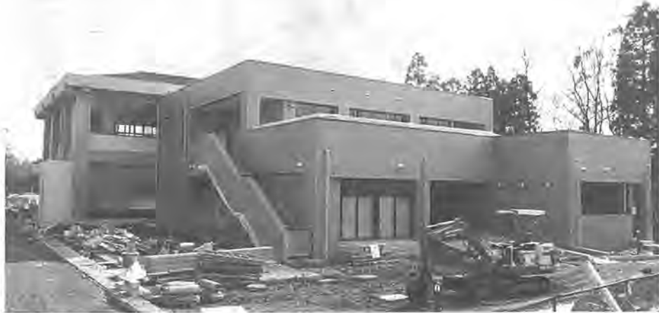
4月オープンを目指し、工事が急ピッチで進められている北部近隣センター (2月28日撮影)
