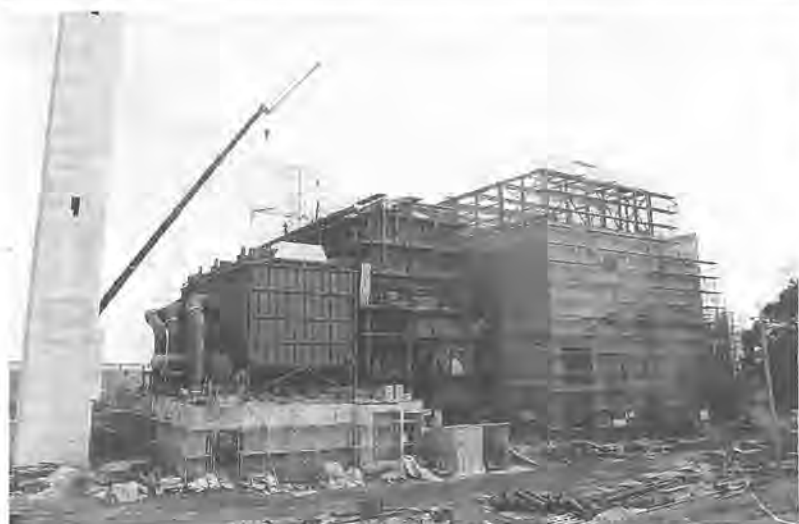
工事の進ちょく率50%の新清掃工場
