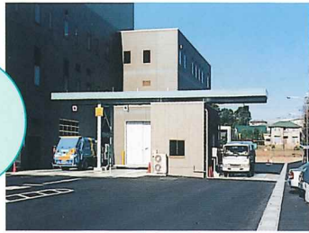
けいりょうとう ■計量棟 搬入車で運ばれたごみを計量します。
