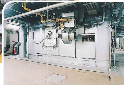
しょうきやくろ がいかん ■焼却炉(外観)
