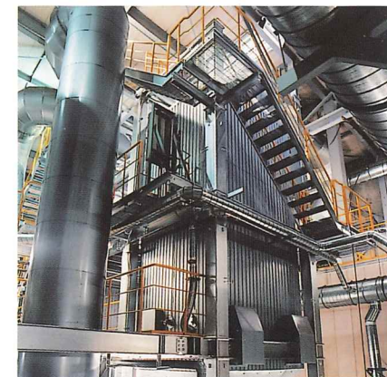
しよくばいはんのうとう ■触媒反応塔 排ガス中の窒素酸化物を除去します。
