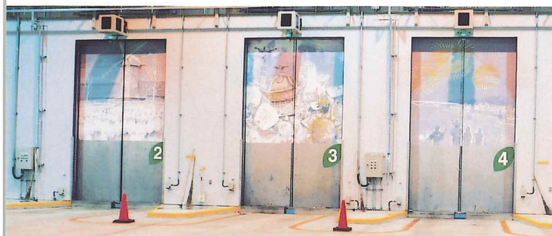
■プラットホームの扉
