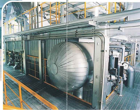
じょうき はつでんき ■蒸気タービン発電機 ボイラで発生した蒸気を利用してタービンを回し、最大2,500kWの発電を行います。
