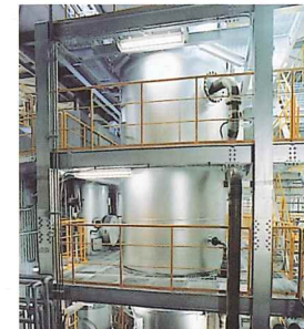
しつしきせんえんとう ■湿式洗煙塔 排ガス中の有害物質を除去するため、水で洗浄します。
